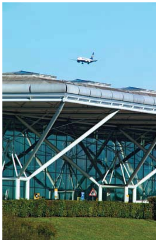
Аэропорт Стэнстед. Лондон, Великобритания. Фрагменты фасада
