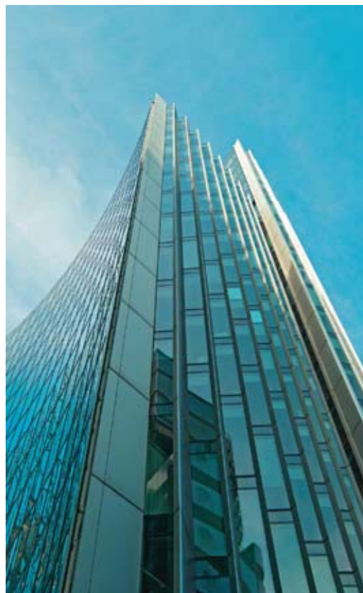
Фрагмент торцевого остекления
