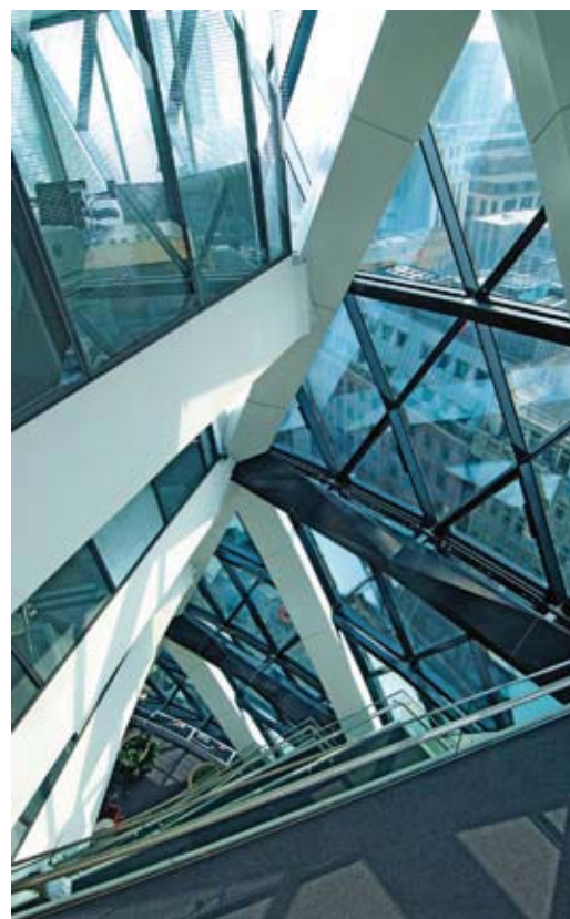
Стыковка несущей конструкции и остекления. Фрагмент
