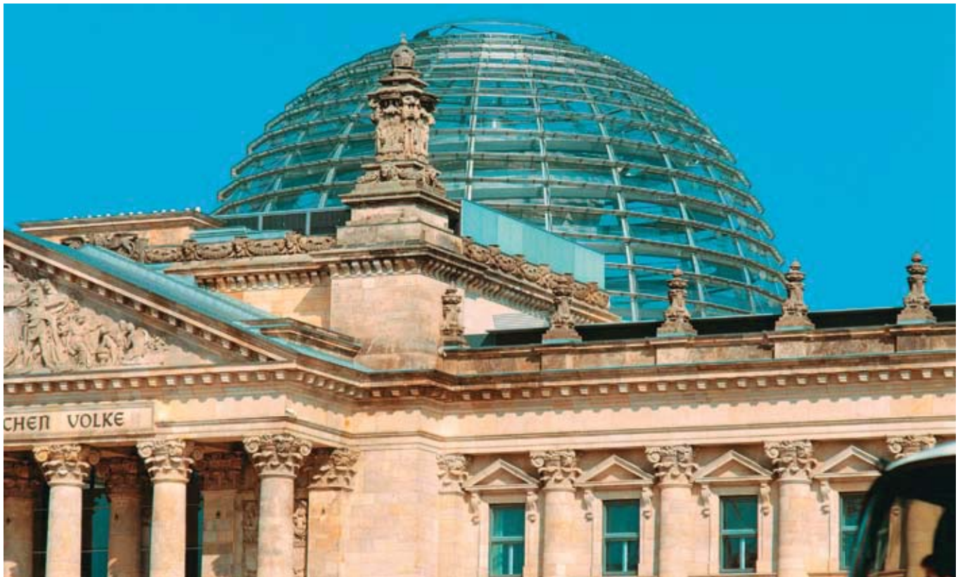
Кровля с куполом. Фрагмент
