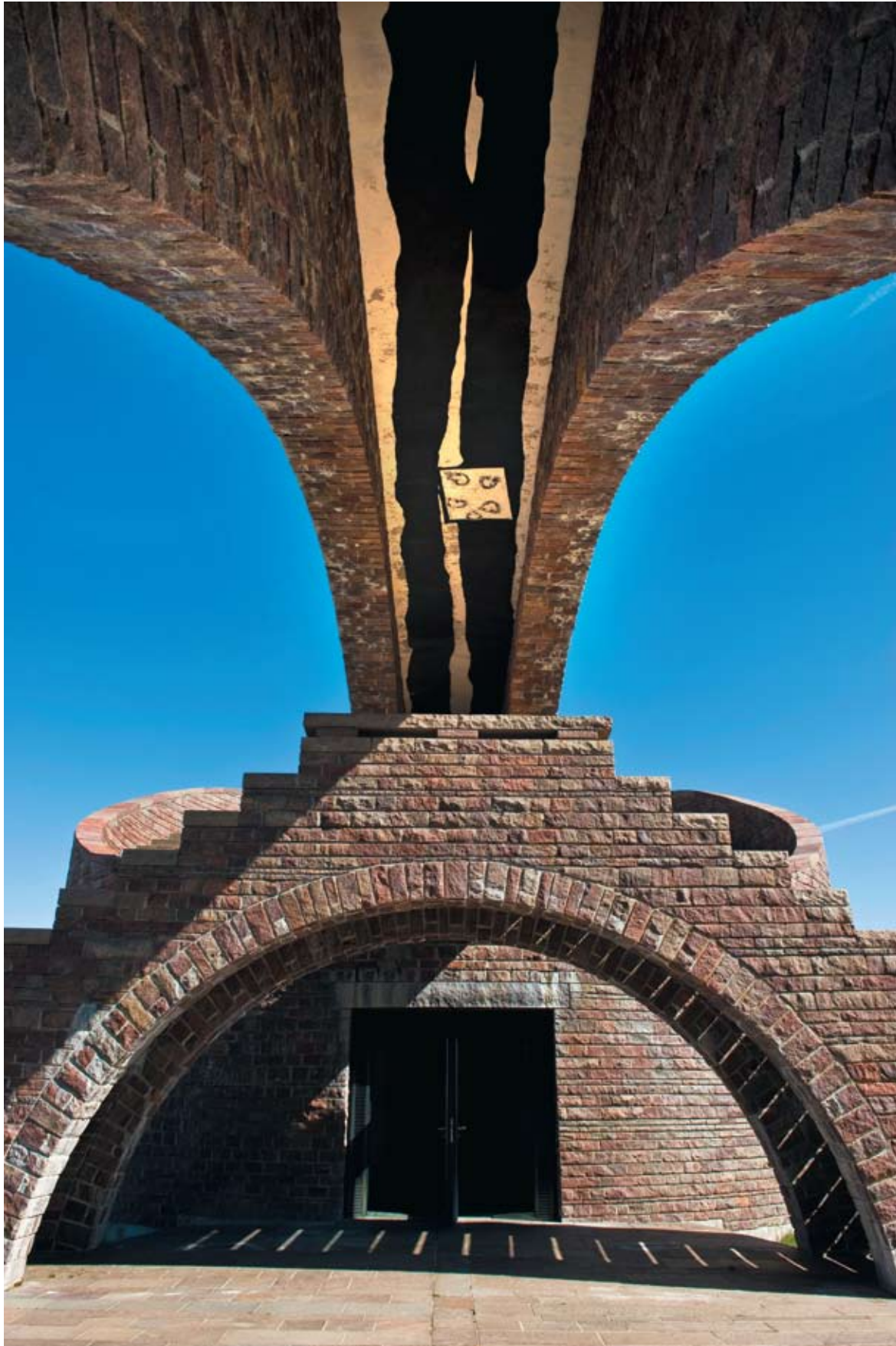
Поперечная лестница и вход в часовню
