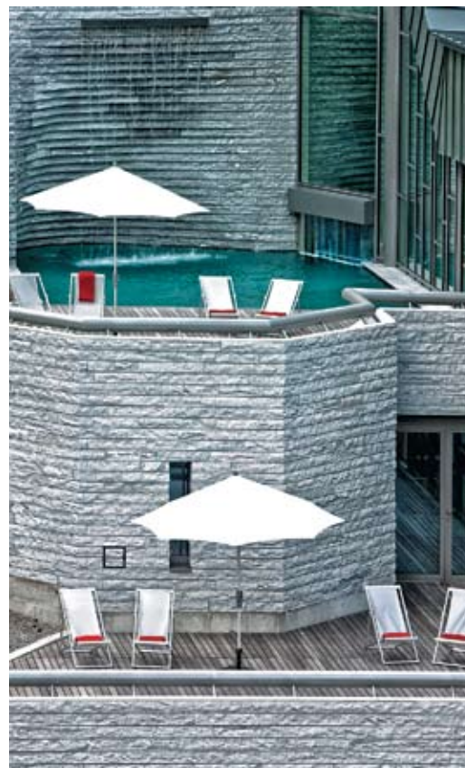
Фасад спа-центра с внешним бассейном. Фрагмент
