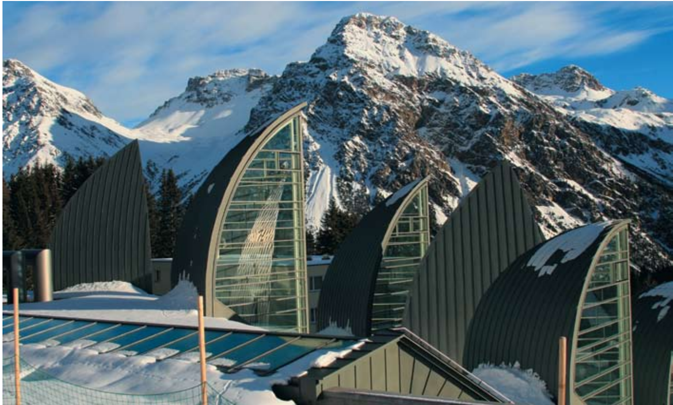
Световые фонари кровли на фоне гор
