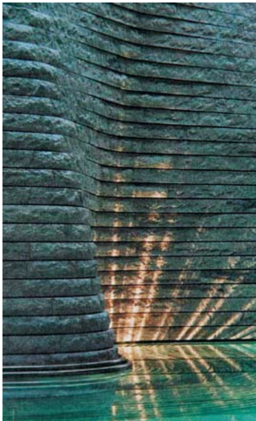
Отделка внутренней стены бассейна. Фрагмент
