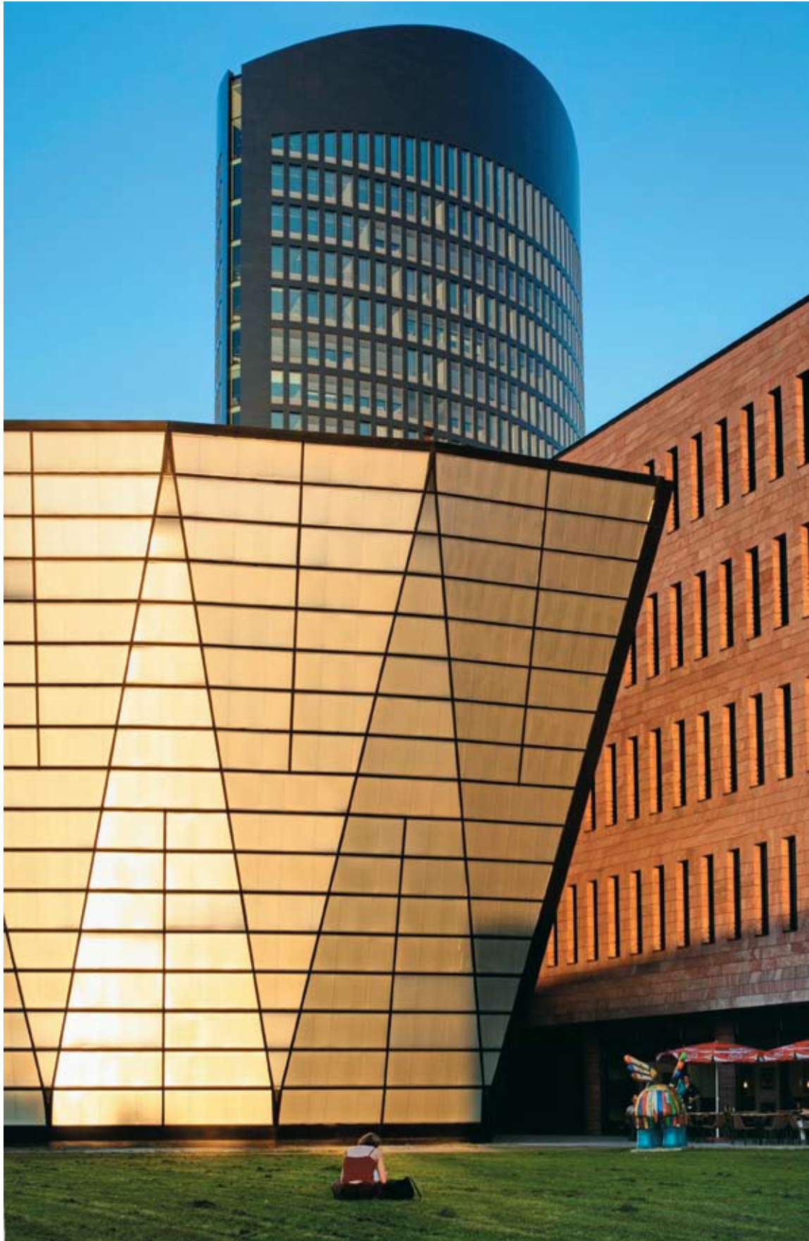
Фасад с солнцезащитным остеклением. Фрагмент
