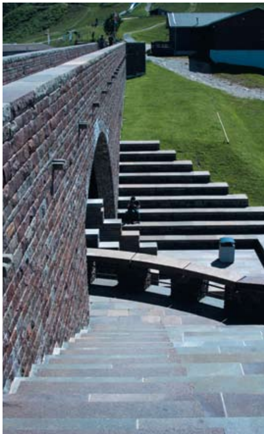
Фрагмент фасада часовни
