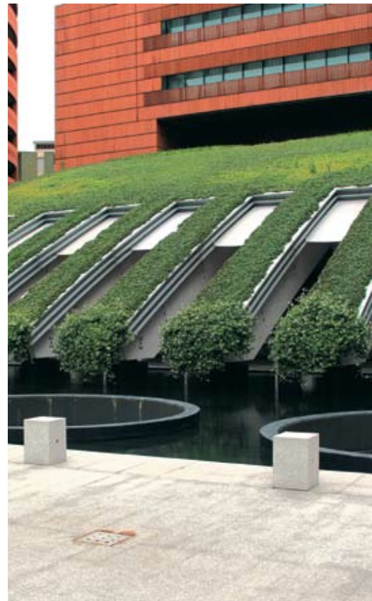
Фрагмент кровли вестибюля
