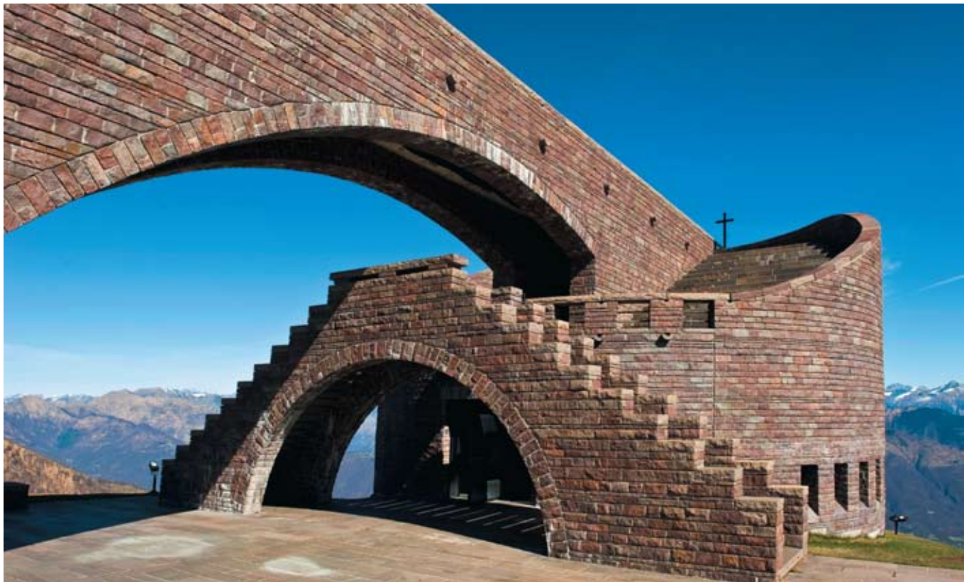
Лестница и нижняя смотровая площадка часовни
