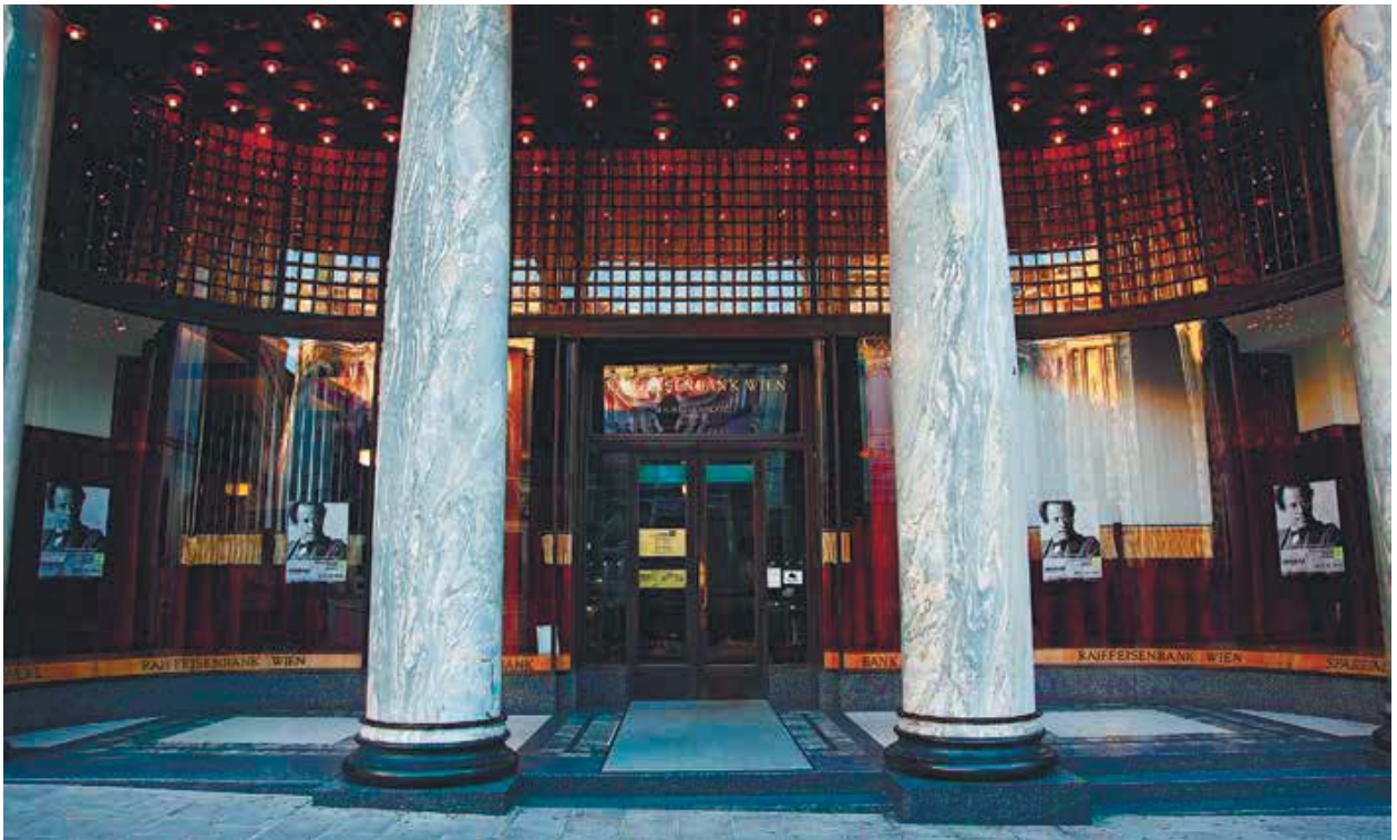
Фрагмент лоджии входа
