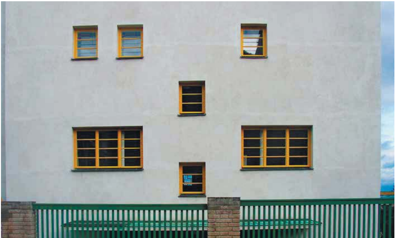
Фрагмент южного фасада
