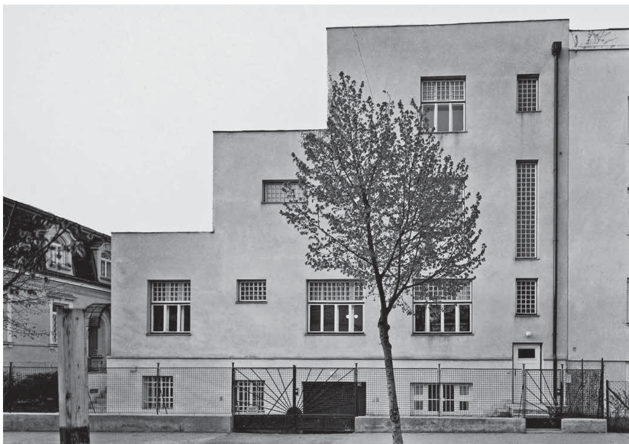
Дом Г. Шоя. Уличный фасад
