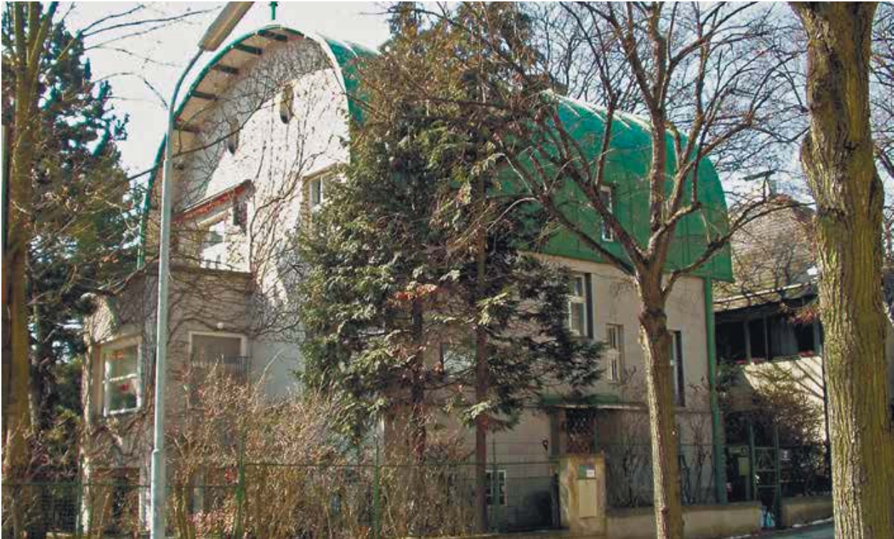
Дом Хорнера. Уличный и боковой фасады
