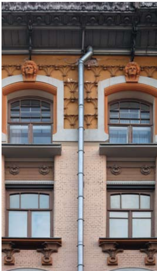
Фрагменты фасадного декора
