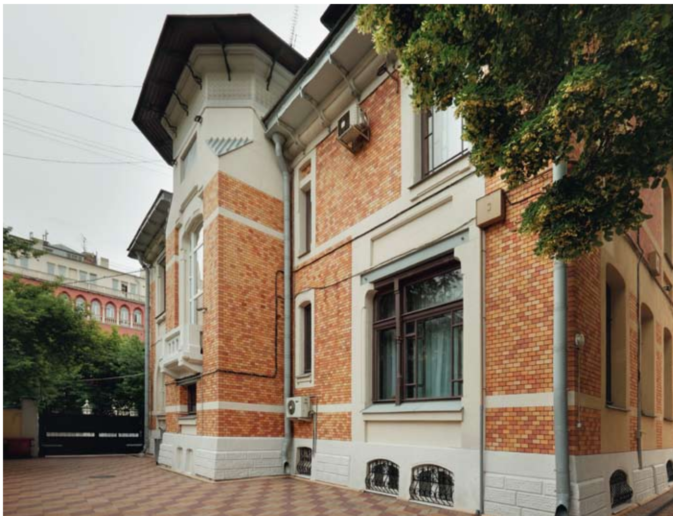
Боковой фасад со стороны двора
