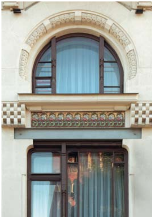
Фрагмент главного фасада
