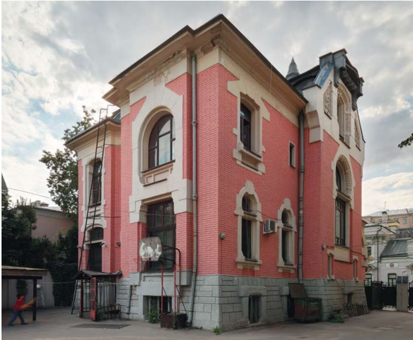
Вид со стороны двора
