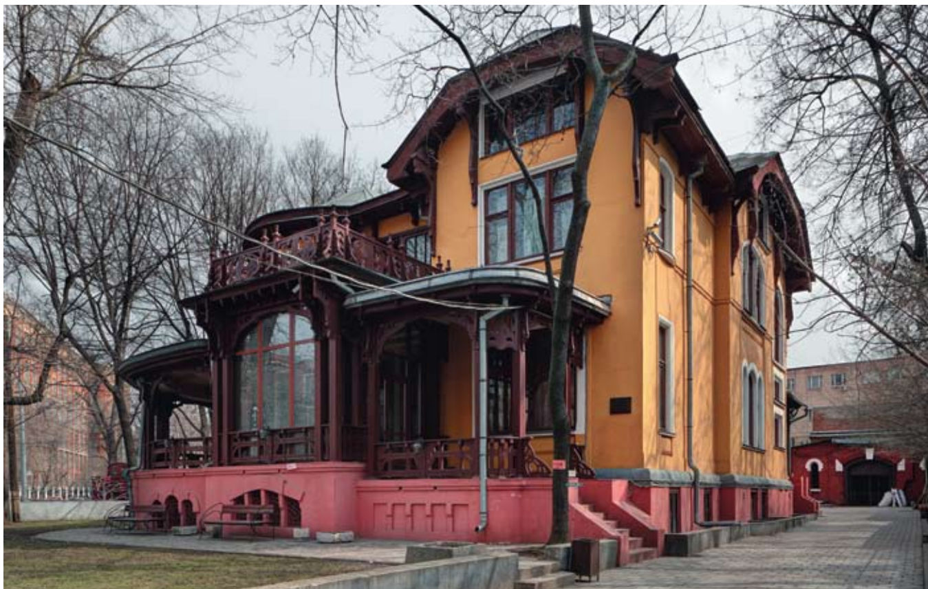
Особняк В. Д. Носова на улице Электrozаводской
