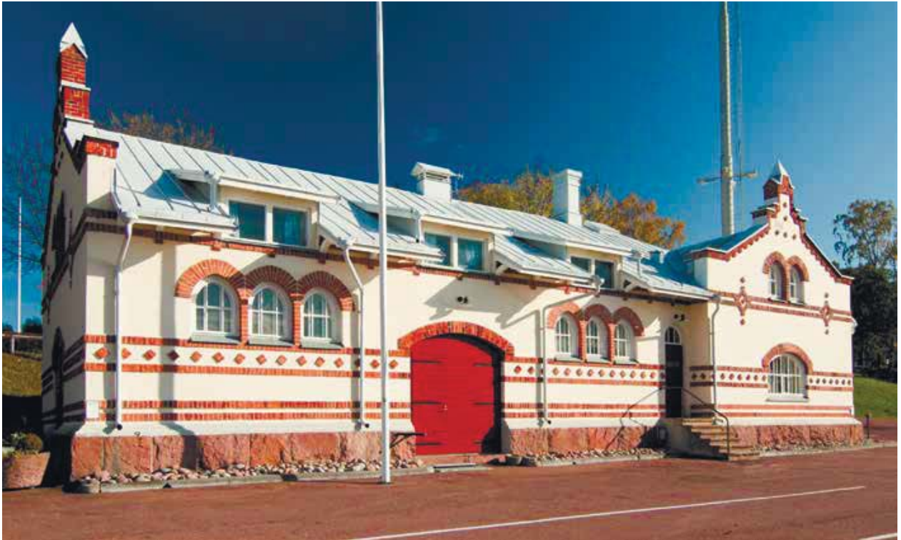
Здание склада. Южный фасад. Мариехамн, Финляндия
