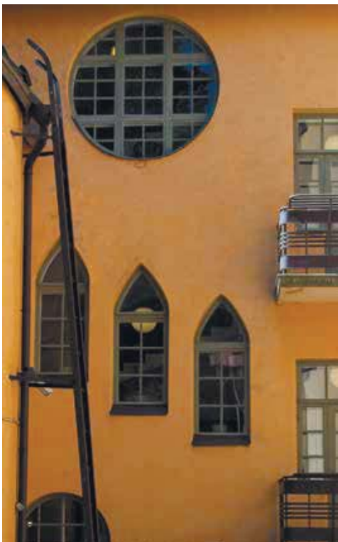
Здание больницы Эйра. Оконные проемы лестничной клетки
