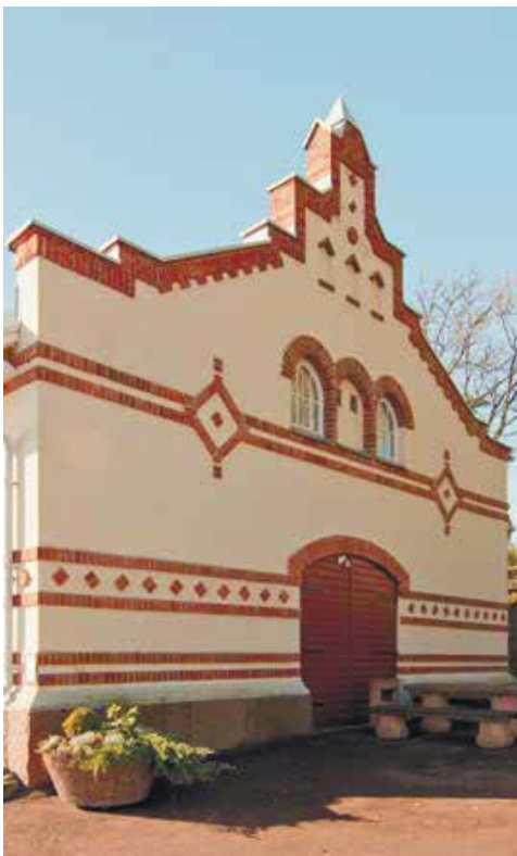
Здание склада. Западный фасад
