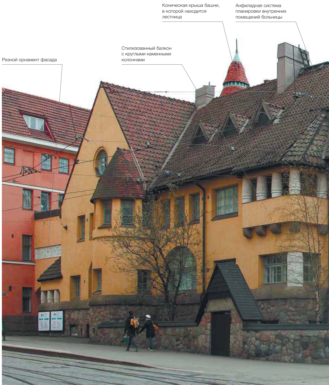
Здание больницы Эйра. Вид с северо-запада
