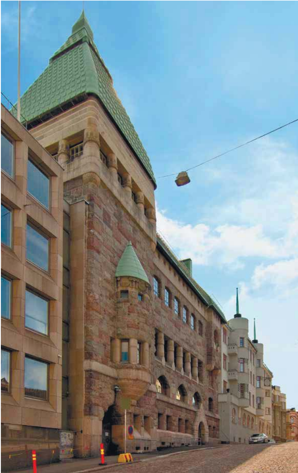
Здание Телефонной ассоциации. Хельсинки
