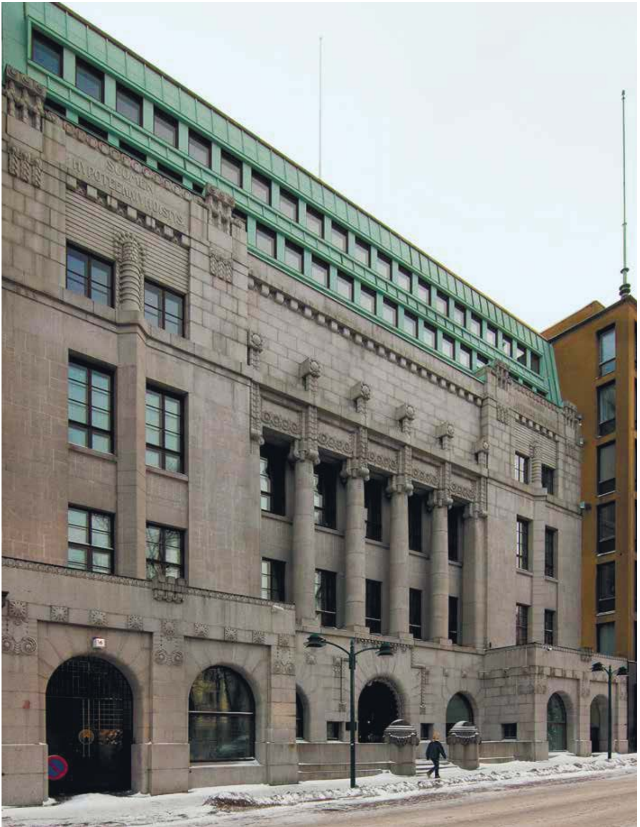
Здание Ипотечной ассоциации Финляндии. Общий вид
