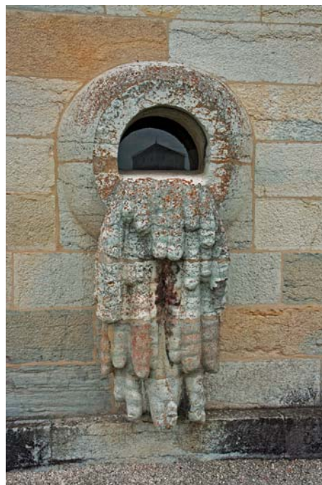
Деталь декора фасада здания для производства соли. Урна с истекающим соляным потоком
