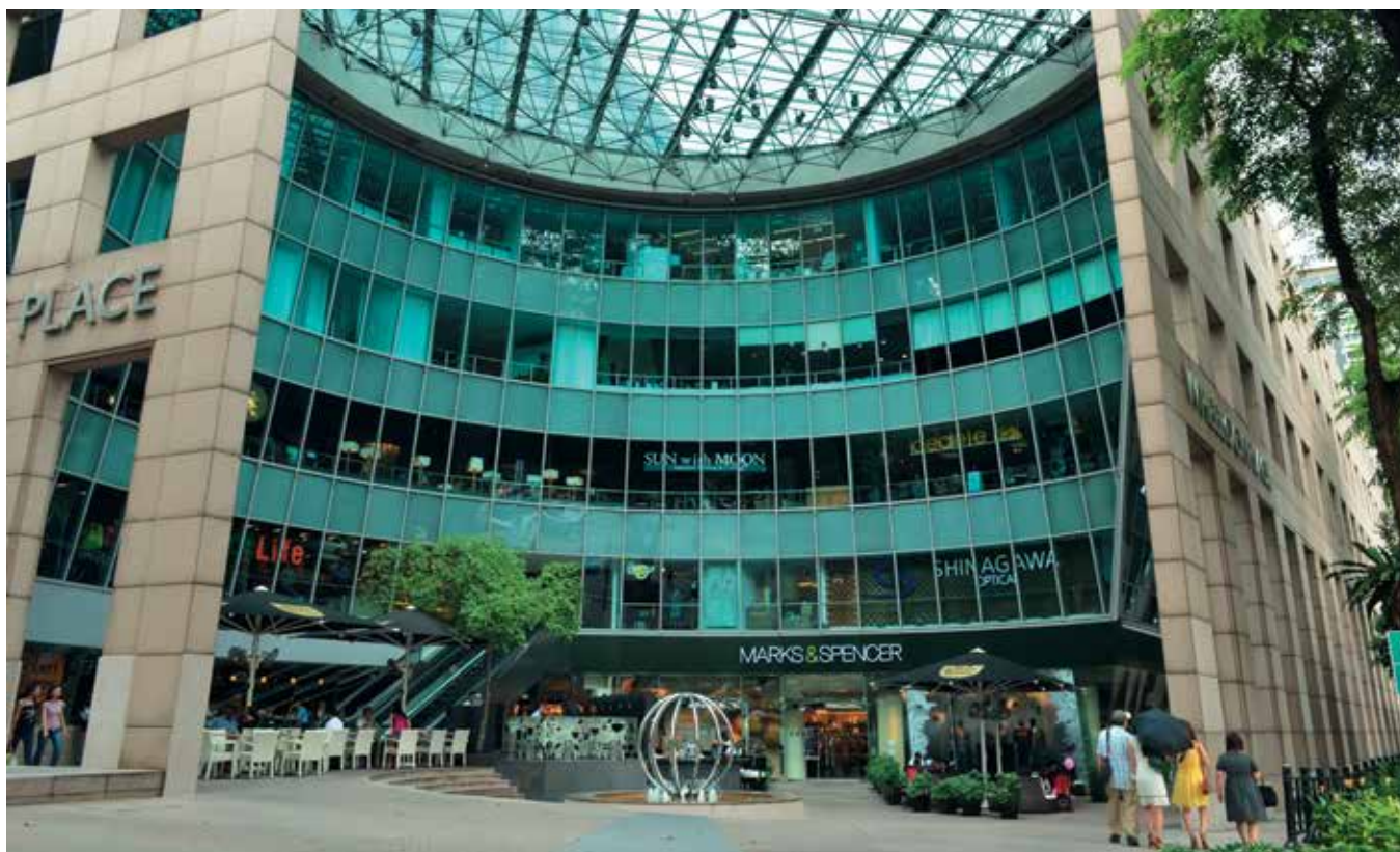
Комплекс «Репаблик Плаза». Крытая площадь входа
