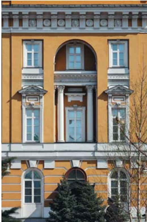
Торцевой фасад. Фрагмент
