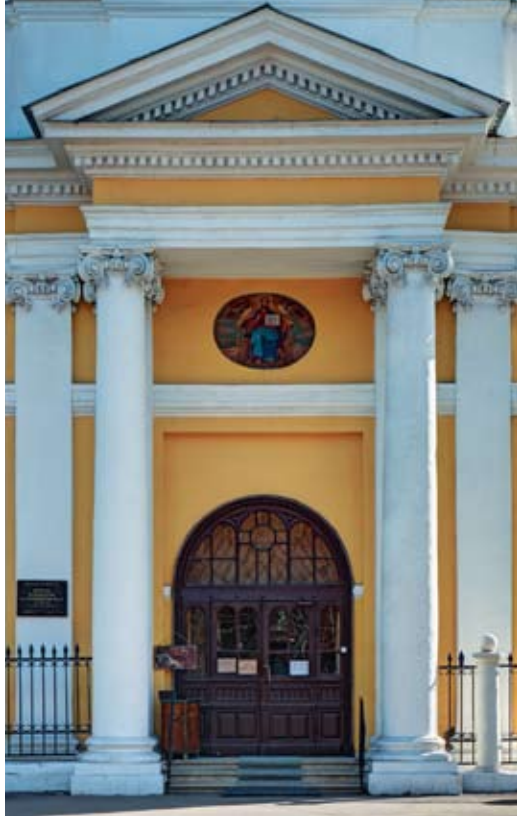
Церковь Вознесения Господня. Фрагмент западного фасада
