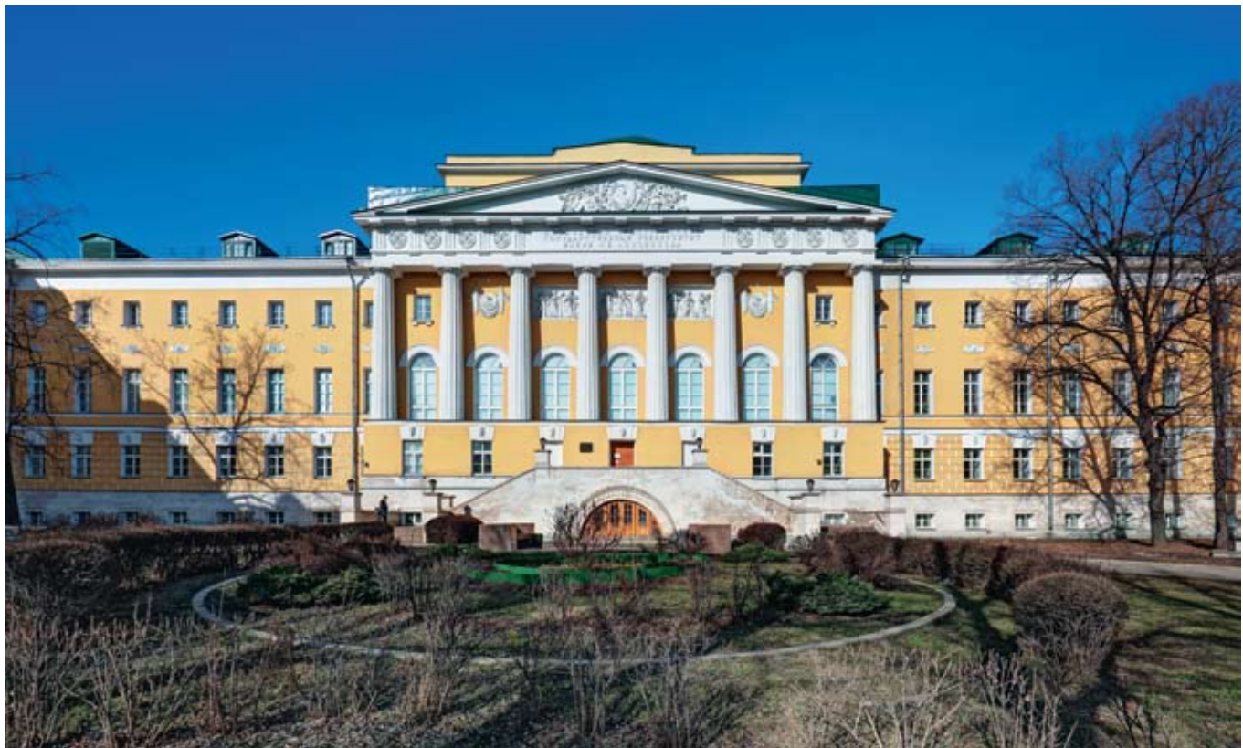
Вид со стороны ул. Моховой
