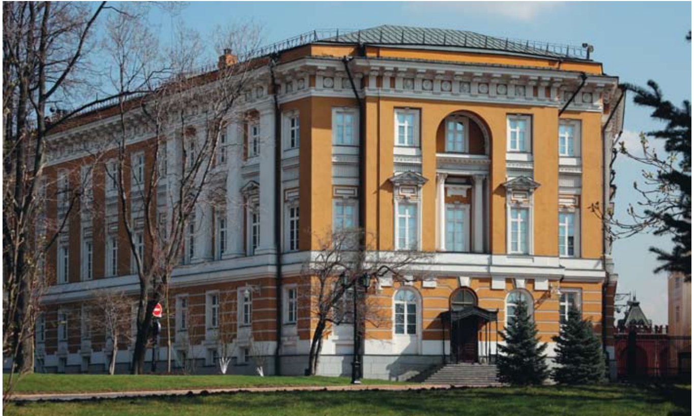
Вид на здание с юга
