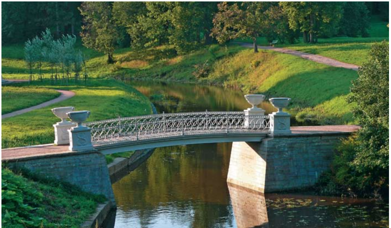
Чугунный мост с вазами через реку Славянку в Павловске
