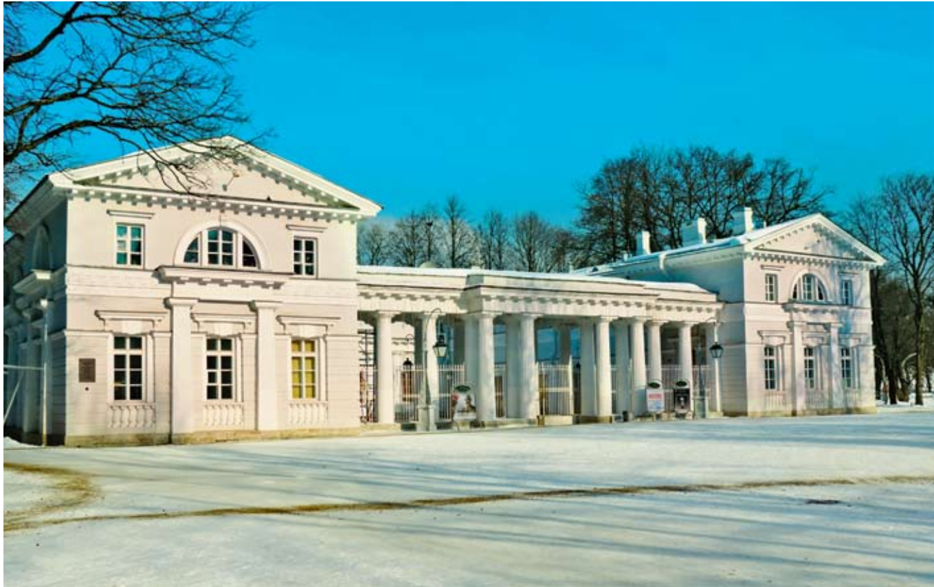
Конюшенный корпус. Южный фасад
