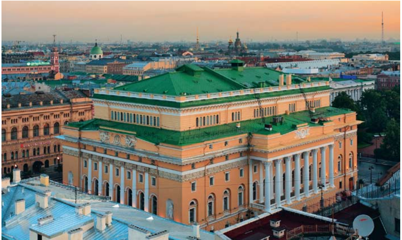
Вид на южный и западный фасады
