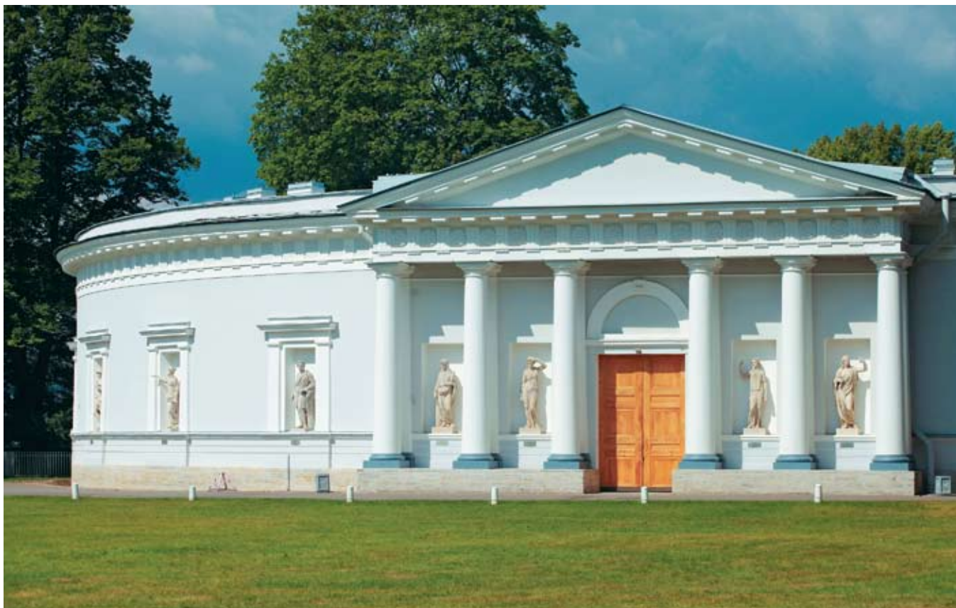
Кухонный корпус. Фрагмент южного фасада
