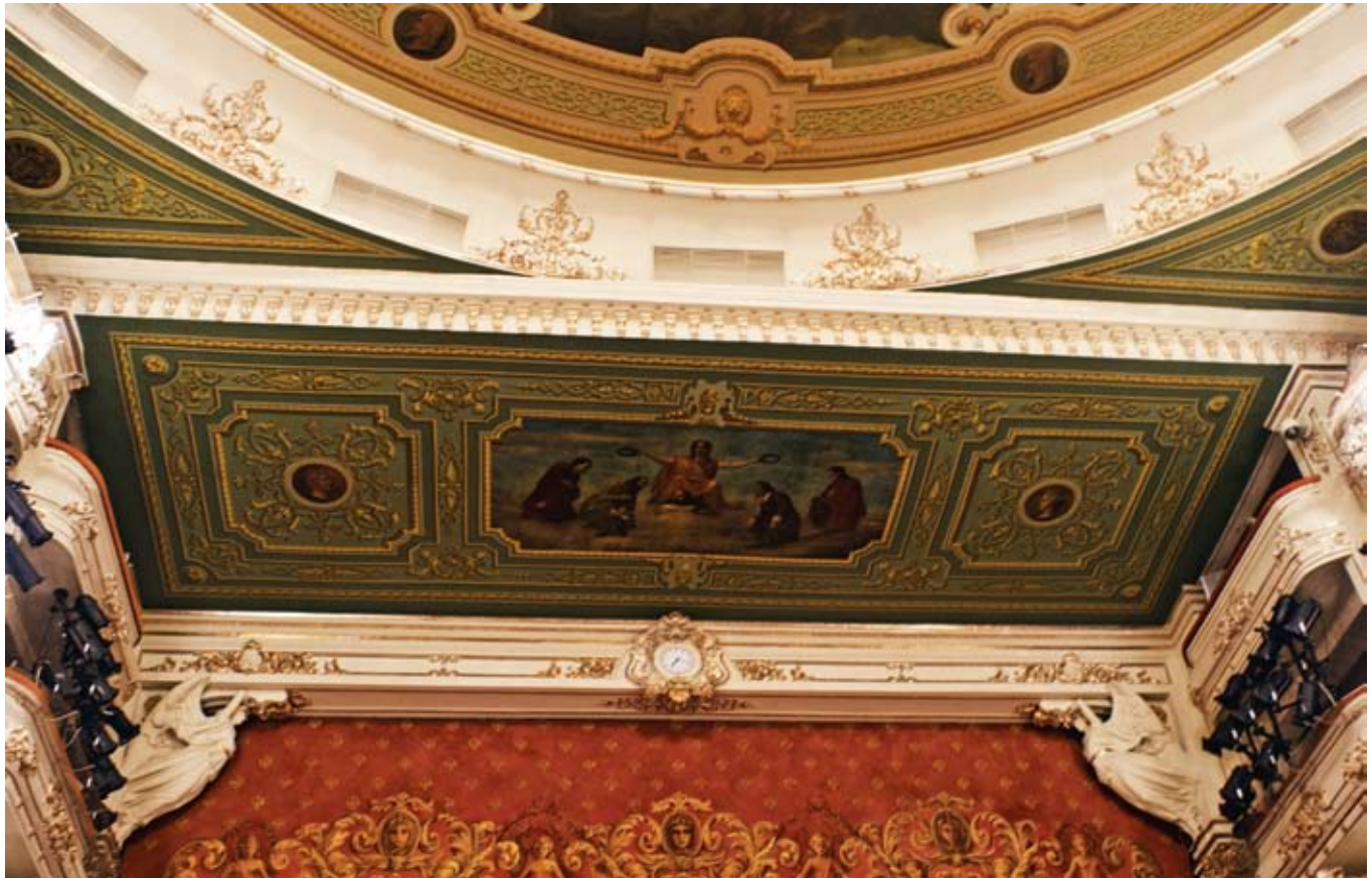
Фрагмент плафона над сценой
