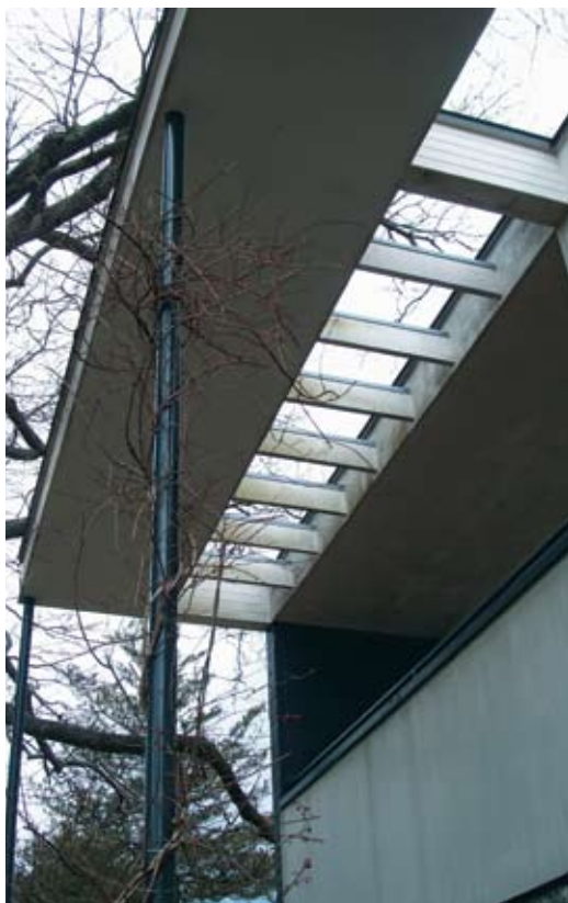
Вид перекрытия крыльца с применением псевдобалочной системы
