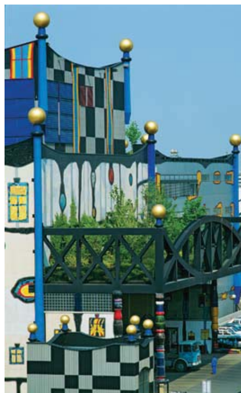
Мусоросжигательный завод. Главный вход
