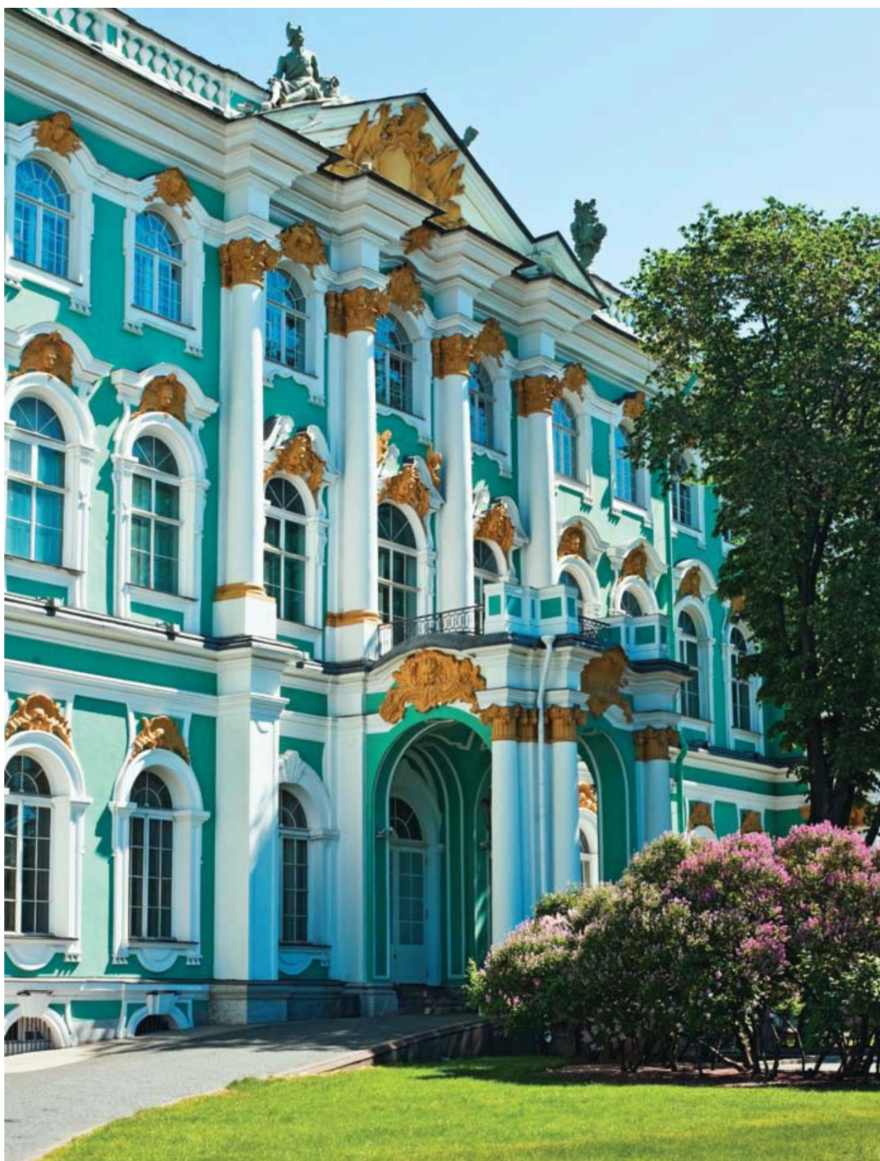
Зимний дворец в Санкт-Петербурге. Фрагмент западного фасада
