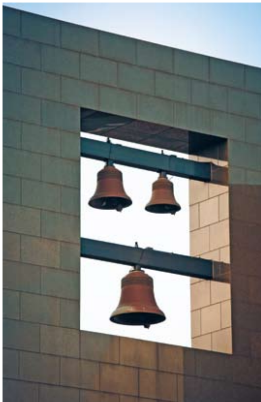
Гранитная стена с двумя ярусами прямоугольных окон и с большим сквозным «окном» в верхней части, где устроена настоящая колокольня
