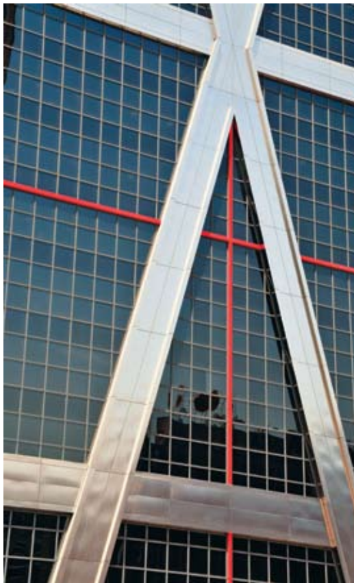
Металлическая сетка, наложенная на фасады
