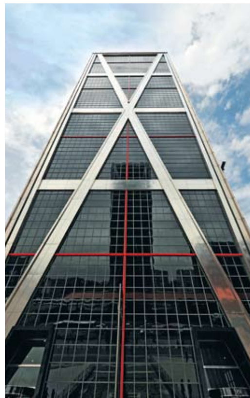
Стальные пластины на фасаде, наложенные по диагонали крест-накрест и визуально «строинящие» здание
