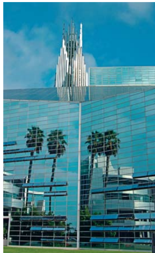
Стеклянные панели облицовки собора
