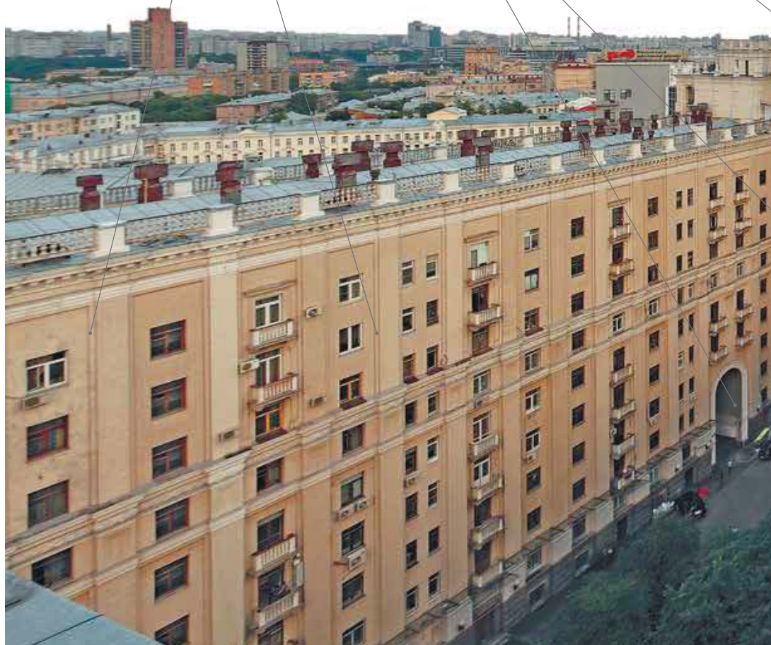
Высотный дом МПС. Вид с крыши во двор
