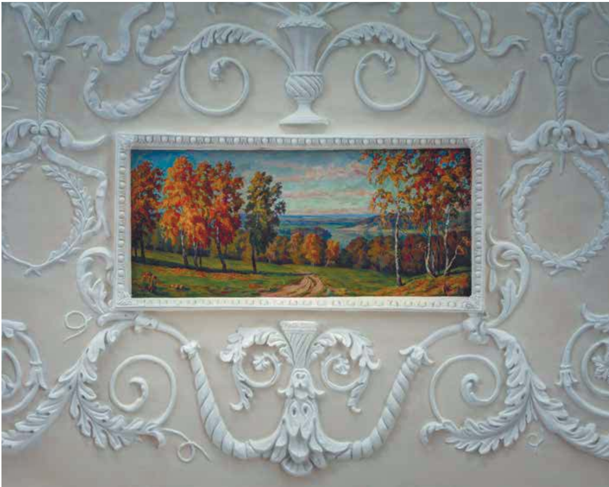
Зал ожидания. Деталь свода
