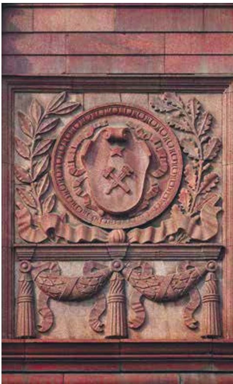
Деталь парадного подъезда. Герб МПС
