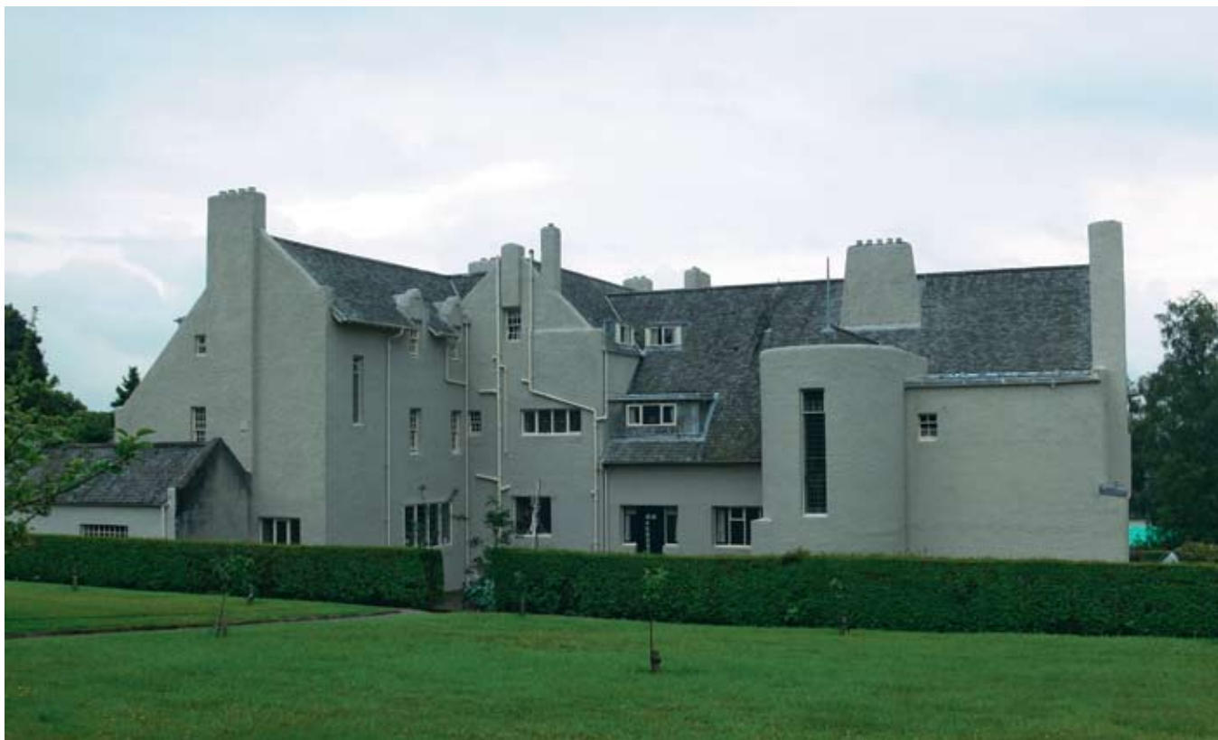
Вид на северный фасад
