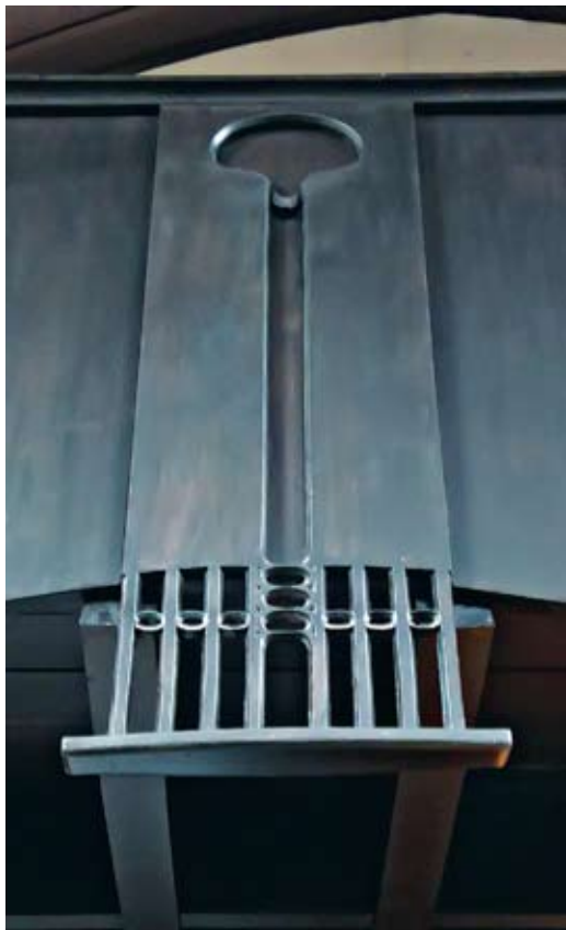
Фрагмент консоли балкона
