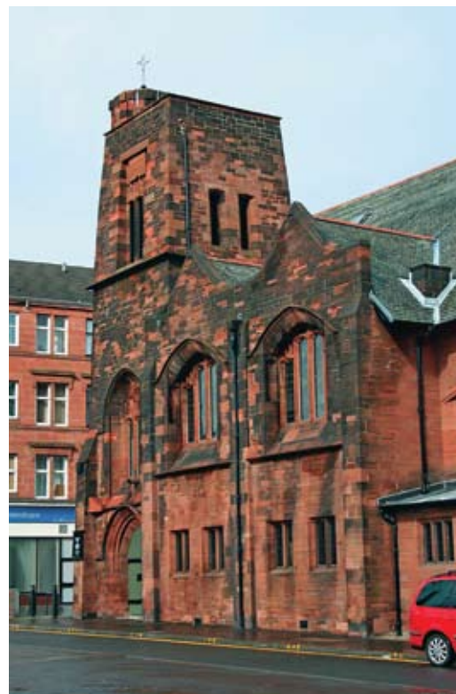
Фрагмент южного фасада
