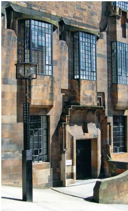
Фрагмент западного фасада, боковой вход
