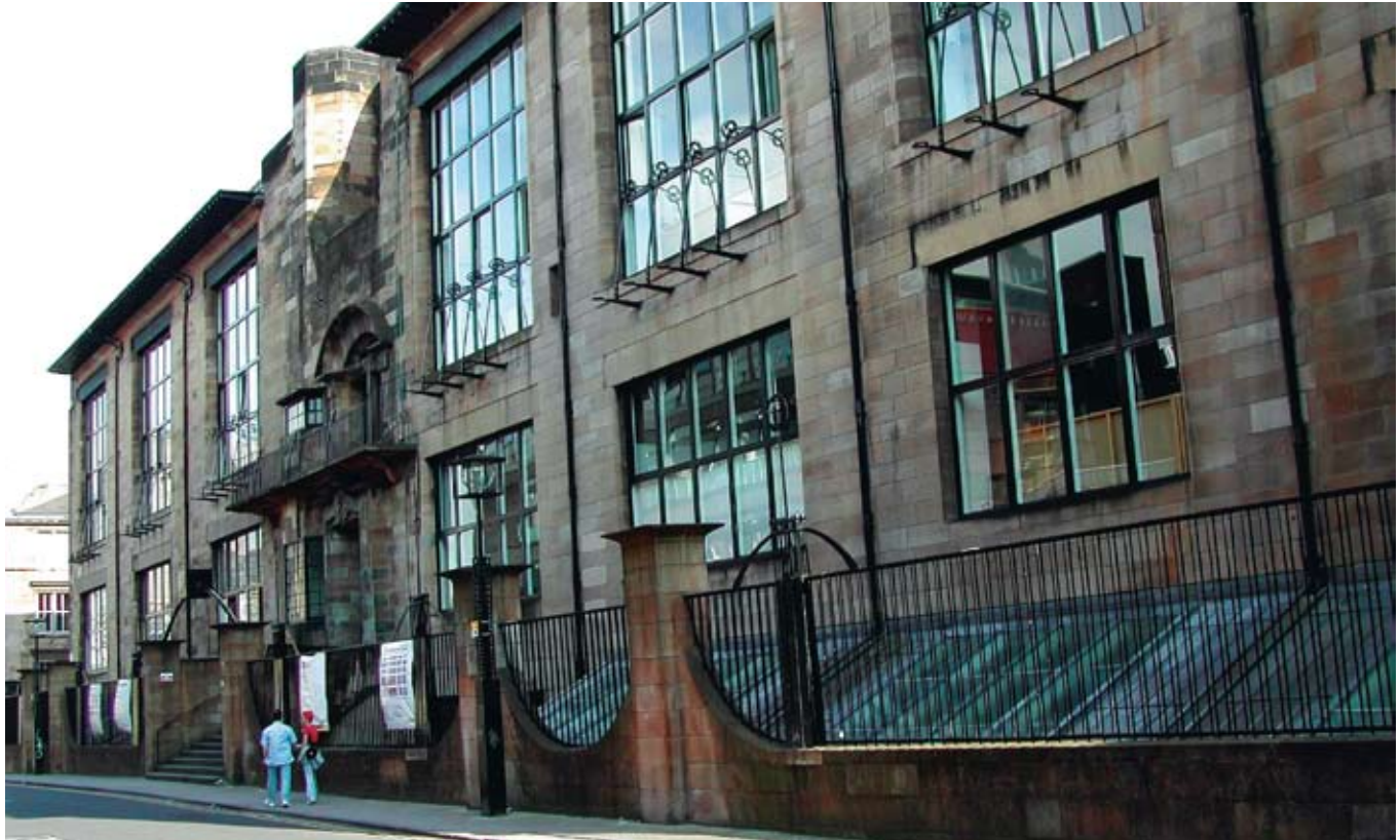
Главный (северный) фасад
