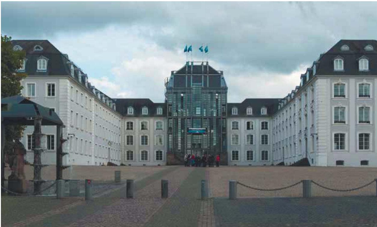
Модернизация замка в Саарбрюккене. Обновленный фасад. Саарбрюккен, Германия
