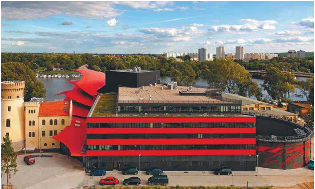
Общий вид театра со стороны городской застройки
