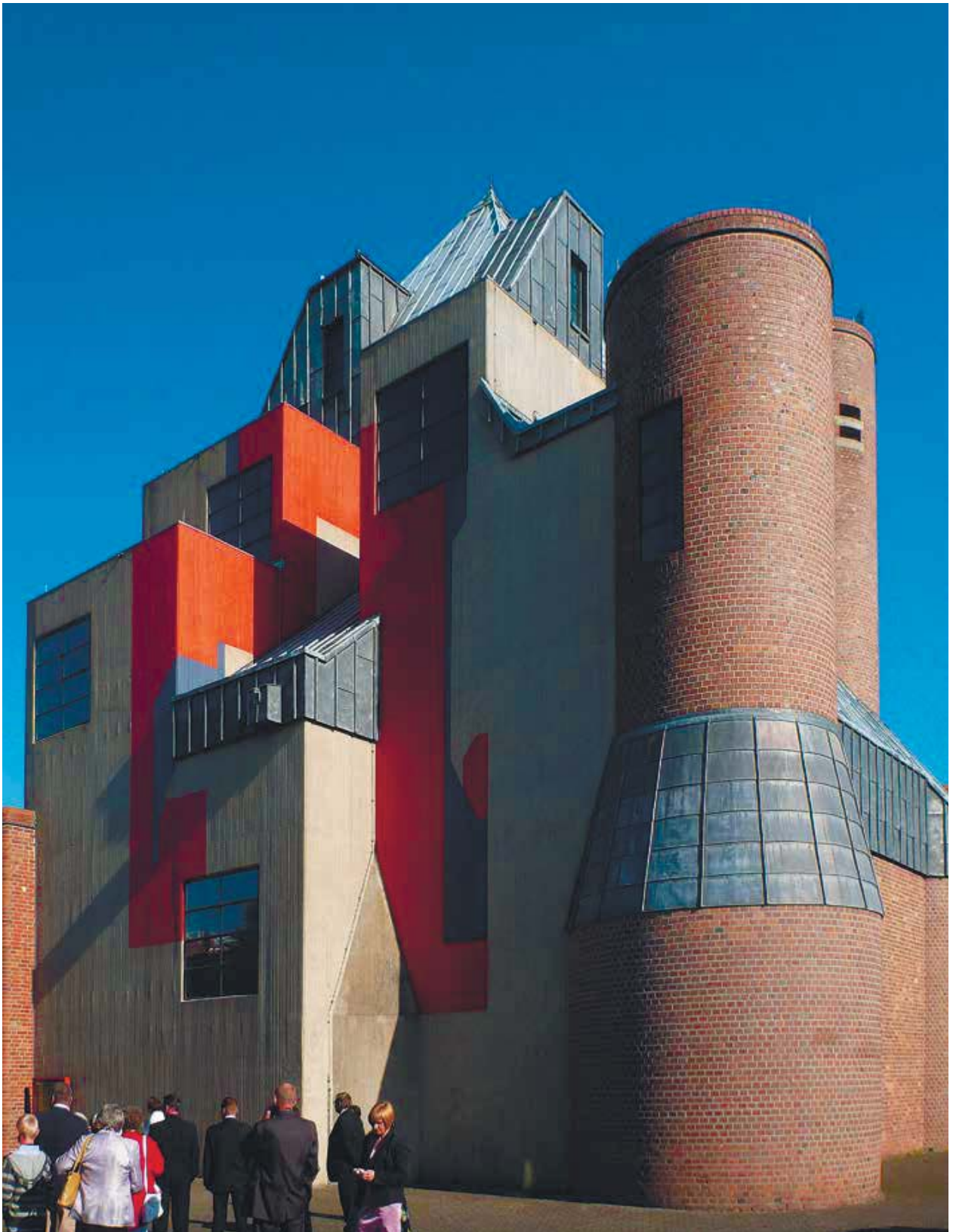
Фрагмент главного фасада церкви
