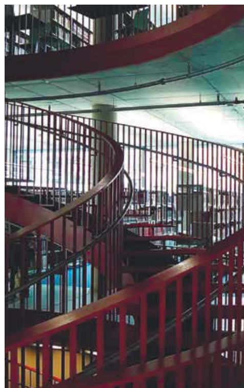
Фрагмент лестничного ограждения
