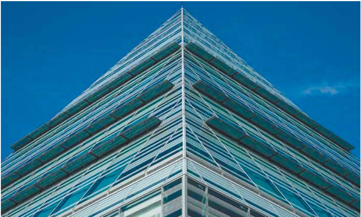
Фрагмент остекления фасада здания
