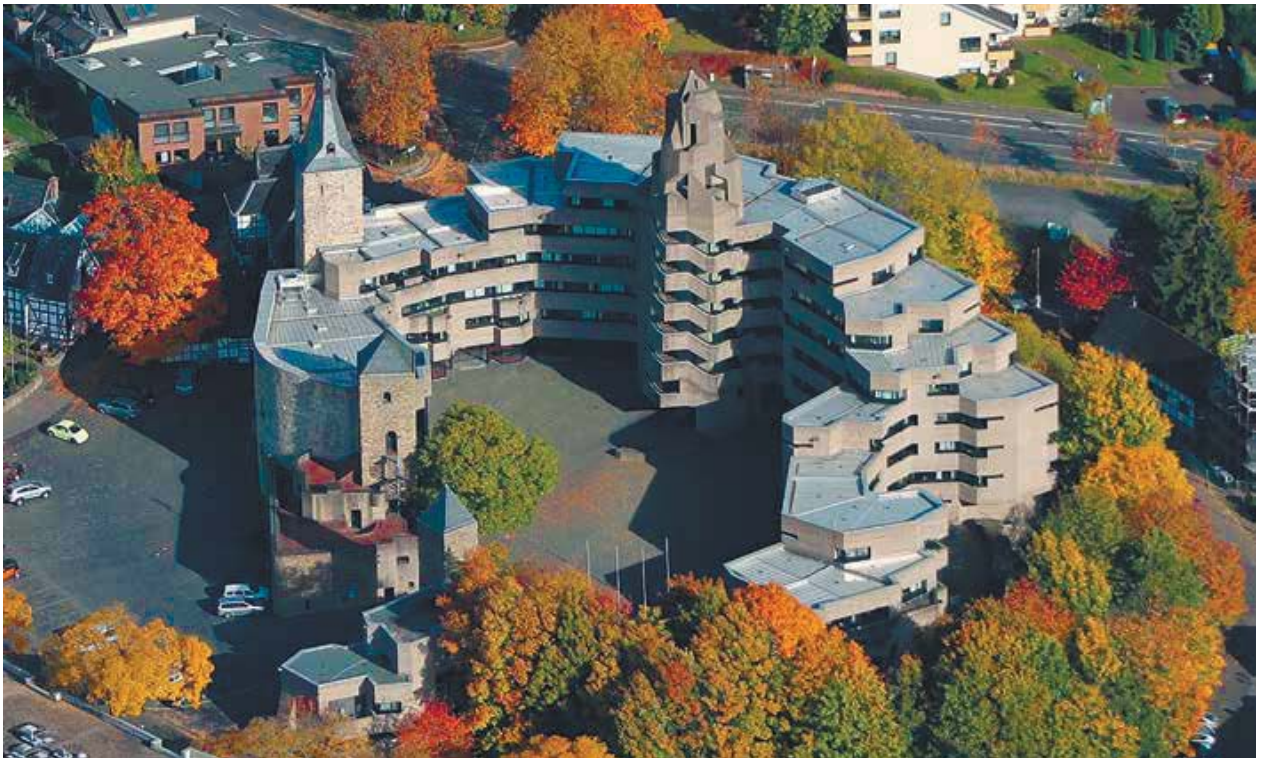
Комплекс ратуши. Вид с высоты птичьего полета
