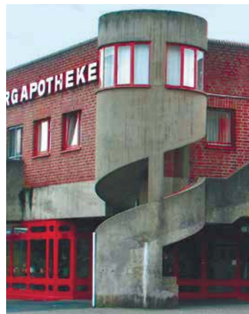
Фрагмент застройки комплекса со зданием аптеки
