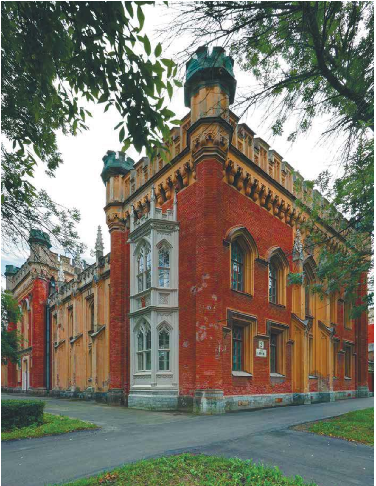
Угловая часть жилого корпуса Придворных конюшен
