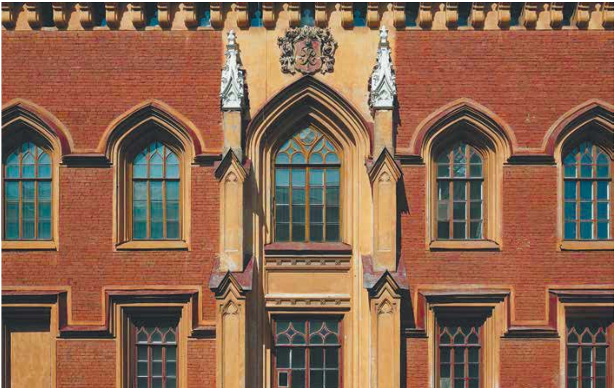
Фрагмент фасада жилого корпуса со стороны ул. Аврова
