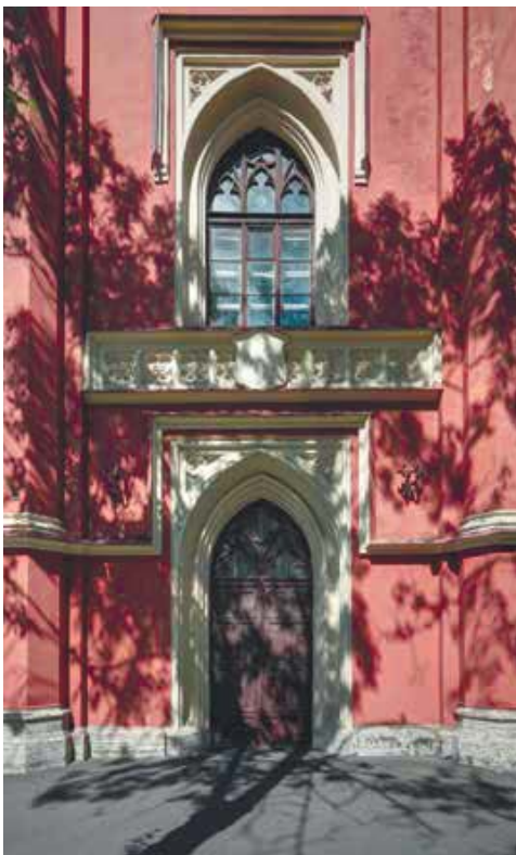
Фрагмент фасада здания
