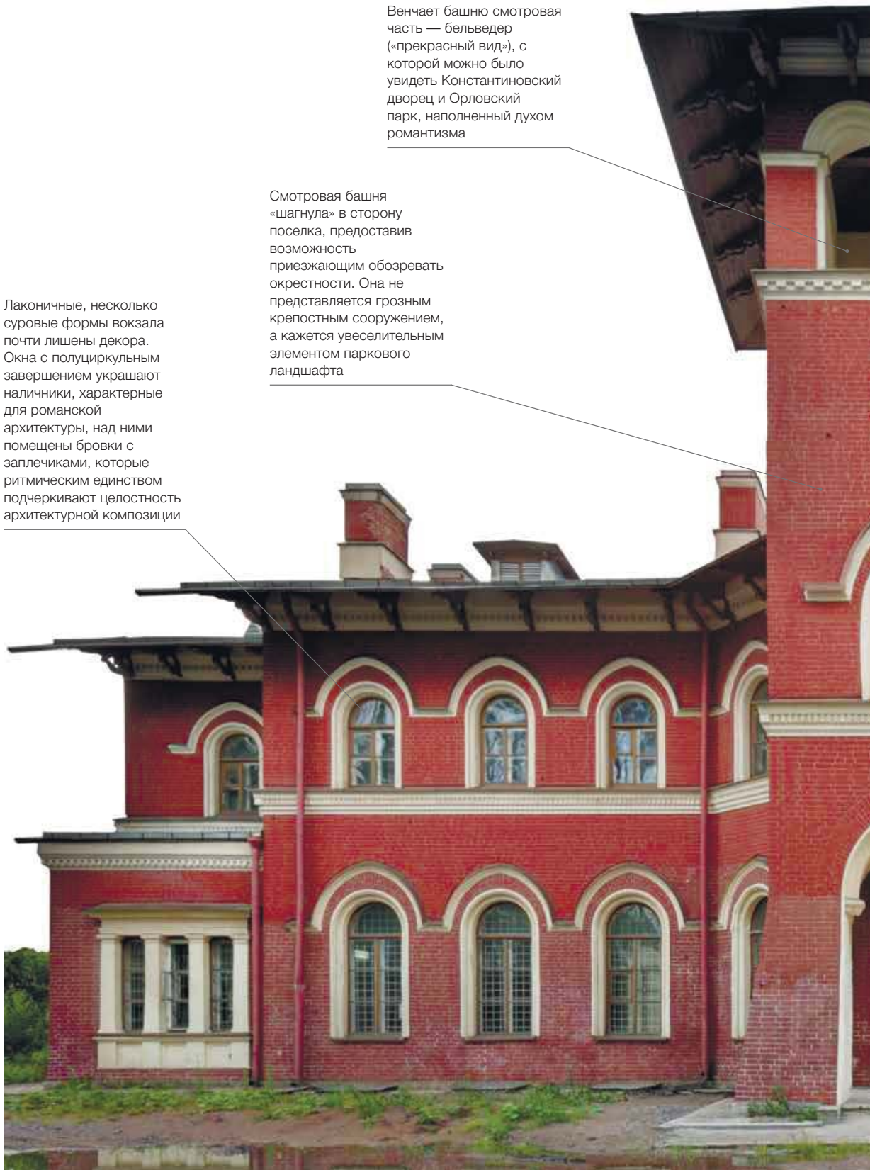
Вокзал в Стрельне. Санкт-Петербург
