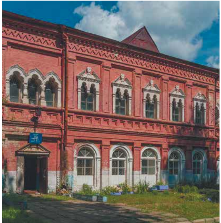
Корпус «выводного зала» конного завода в Высоком. Фрагмент фасада
