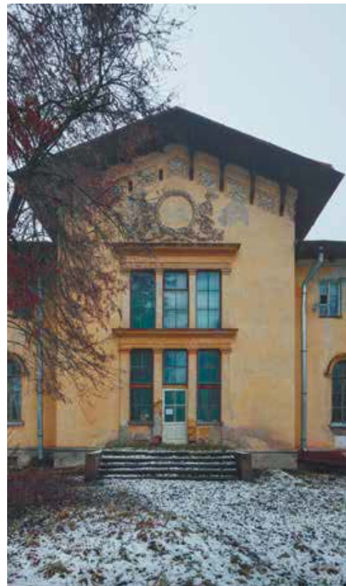
Фрагмент восточного фасада
