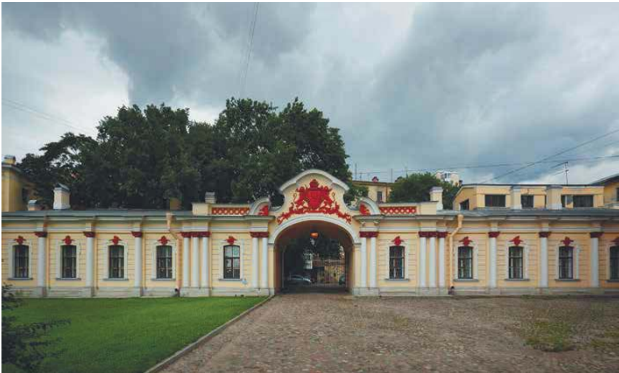
Флигель Шереметевского дворца. Фасад в сторону парадного двора. Санкт-Петербург
