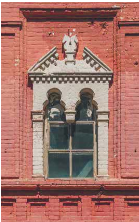
Корпус «выводного зала» конного завода. Окно второго этажа
