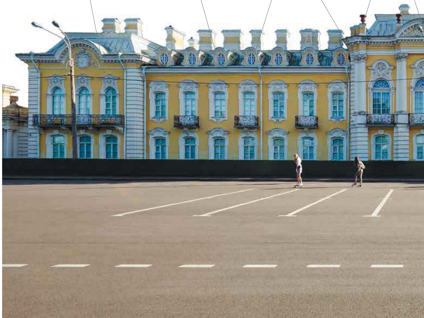
Парадный фасад Фрейлинского корпуса, выходящий на Дворцовую площадь
