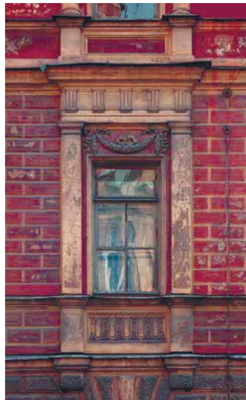
Доходный дом Кребера. Фрагмент фасада
