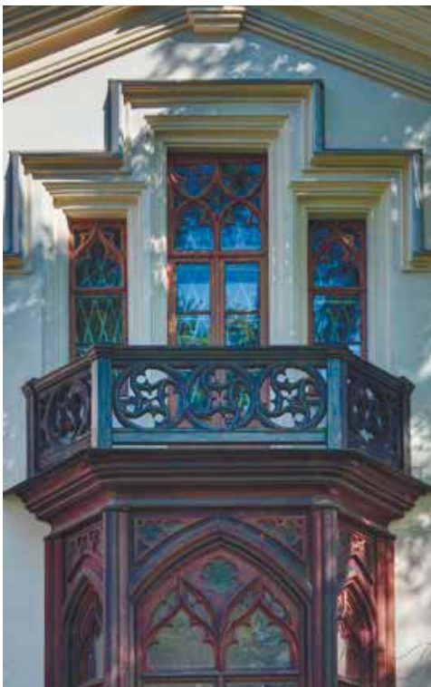
Фрагмент фасада бокового корпуса
