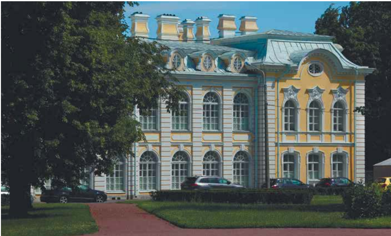
Фрагмент фасада, выходящего на ул. Калининская
