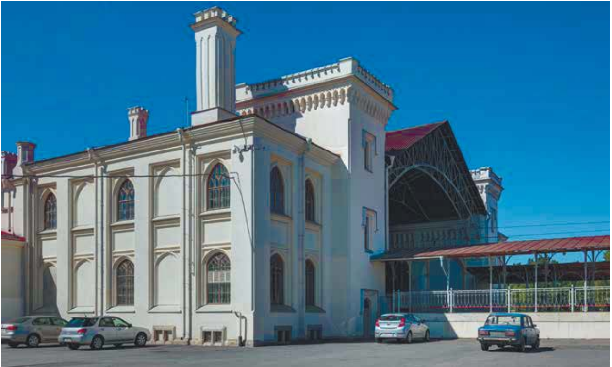
Стисная «крепостными» башнями металлическая арка над дебаркадером на восточной стороне вокзала
