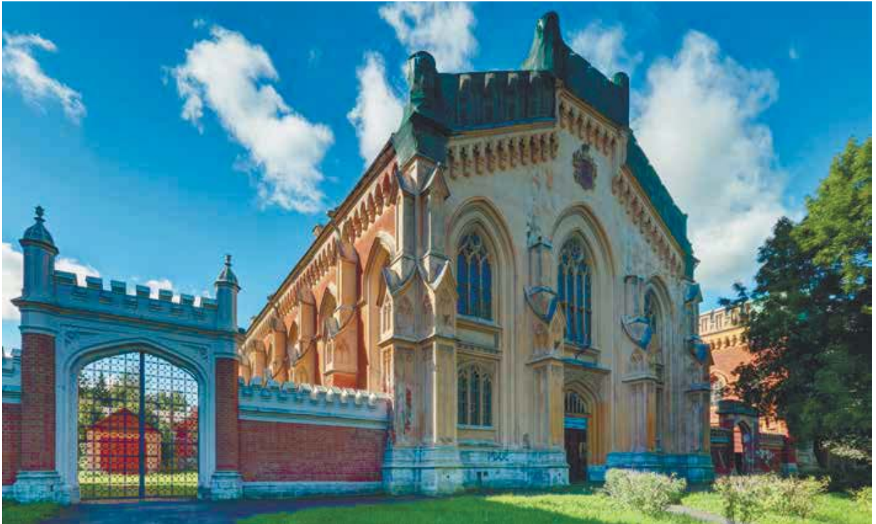
Главный фасад манежа
