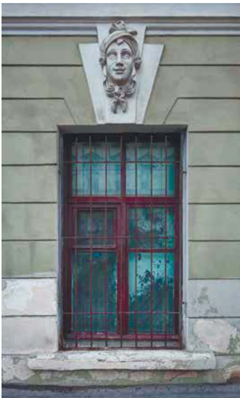
Дом семьи Бенуа. Маскарон над окном первого этажа
