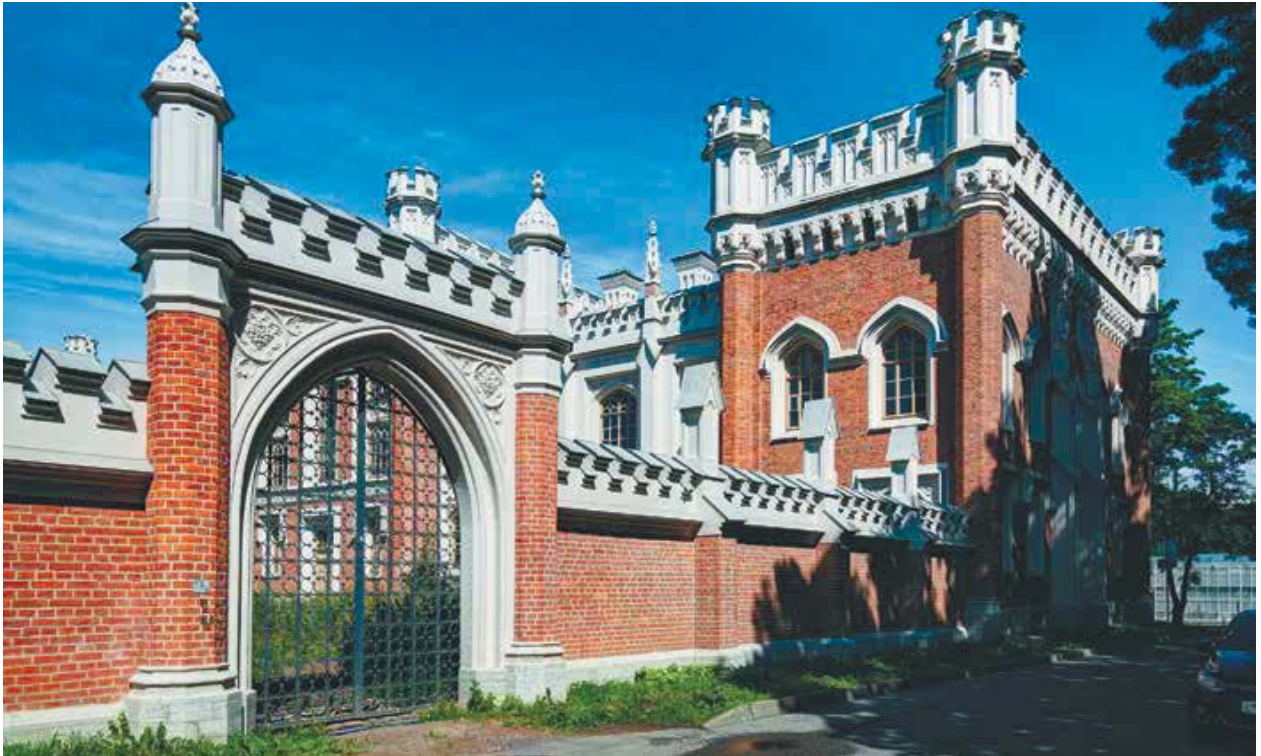
Ворота со стороны восточного фасада
