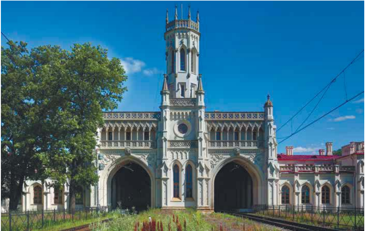
Западный фасад Петергофского вокзала
