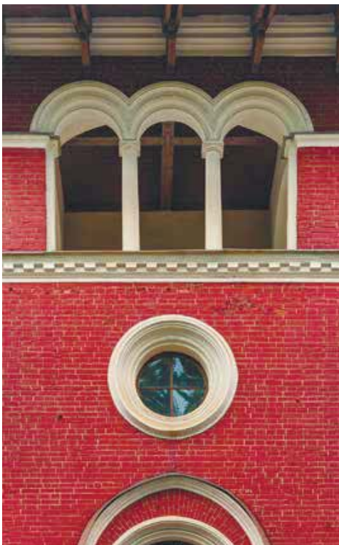
Вокзал в Стрельне. Фрагмент фасада смотровой башни
