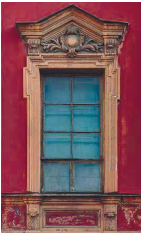
Доходный дом Кребера. Фрагмент фасада
