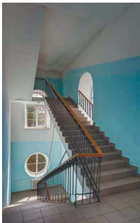
Лестница в торцевой части здания
