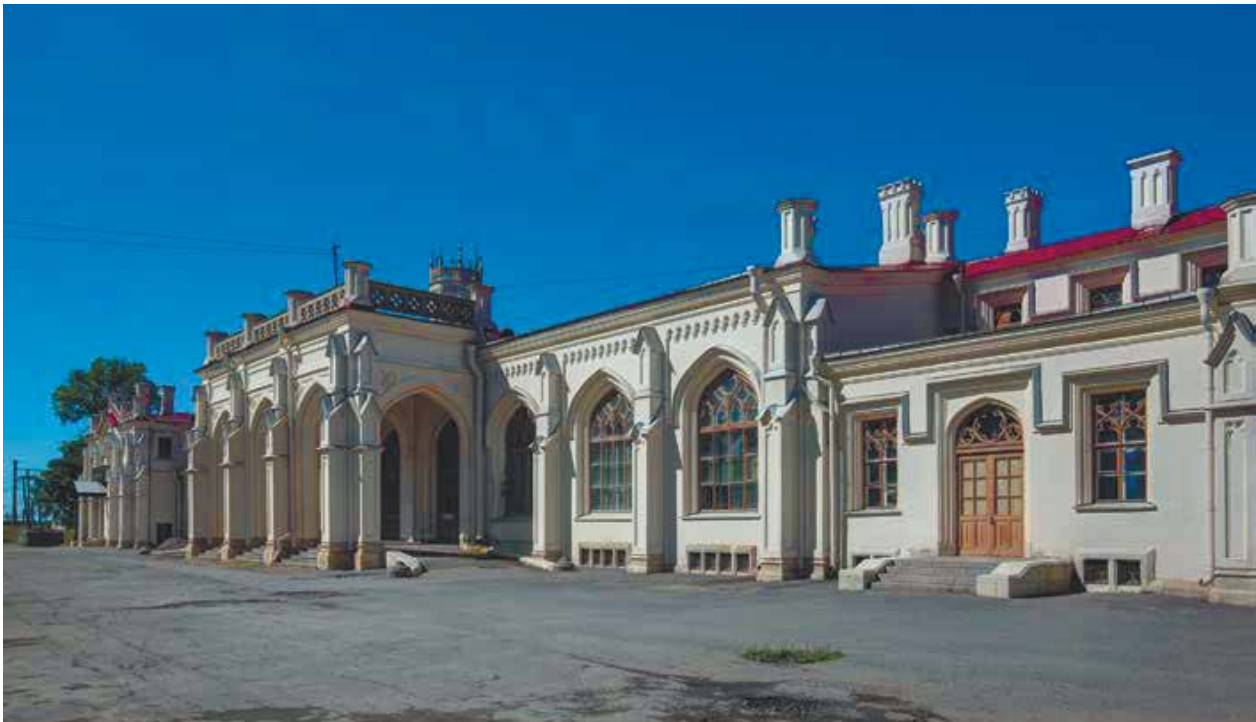
Южный фасад вокзала с парадным подъездным порталом
