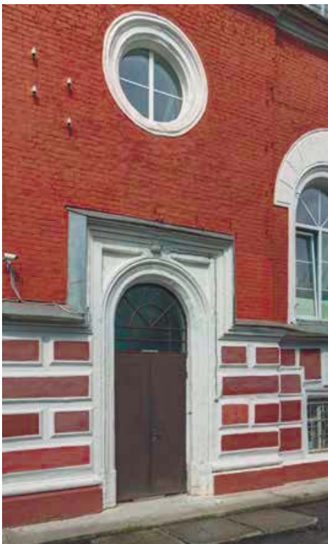
Фрагмент заднего фасада
