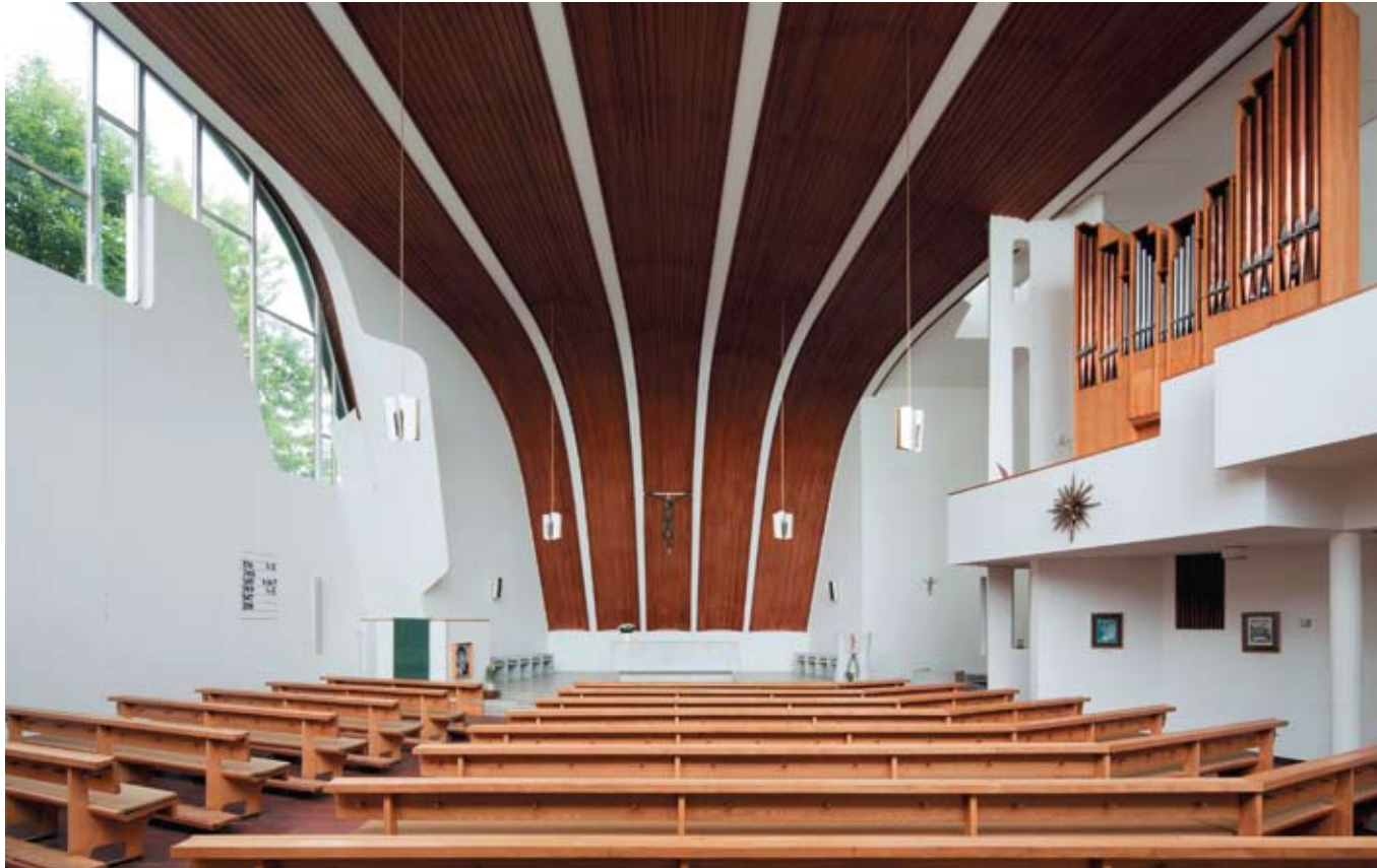
Интерьер церкви в Вольфсбурге. Наклонные железобетонные рамы перекрытия и натуральное дерево между ними
