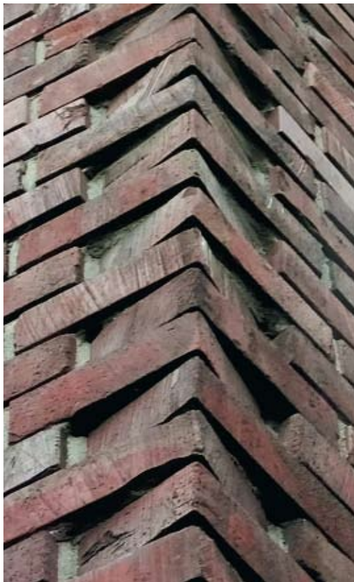
Фрагмент фасада одного из корпусов университета
