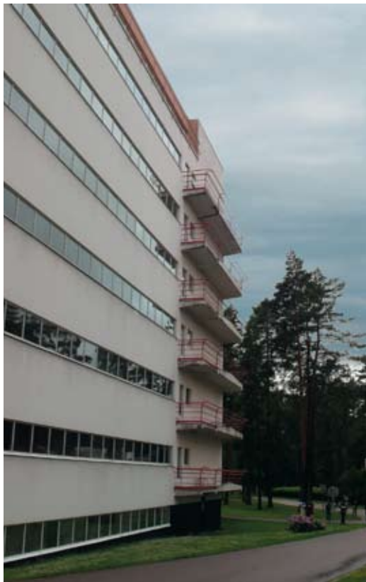
Фрагмент фасада большого лечебного корпуса А санатория
