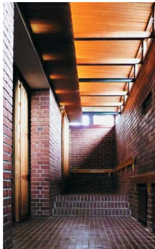
Интерьер административной части общественного центра. Полы и внутренние лестницы отделаны кирпичом
