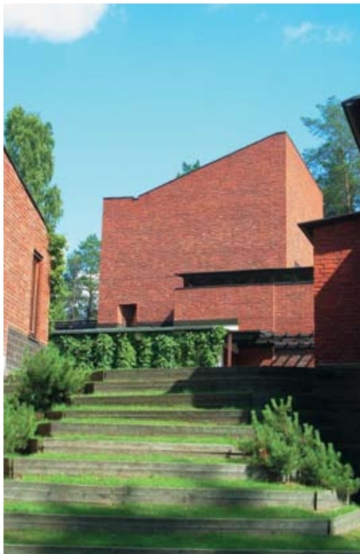
Фрагмент юго-западного фасада общественного центра. «Земляная» лестница со стороны внутреннего дворика
