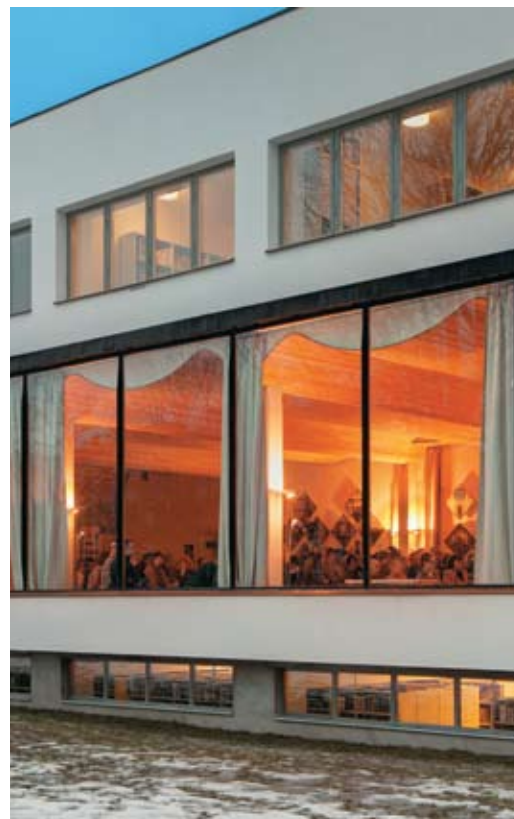
Фрагмент главного фасада (окна административных помещений, лекционного зала и книгохранилища)
