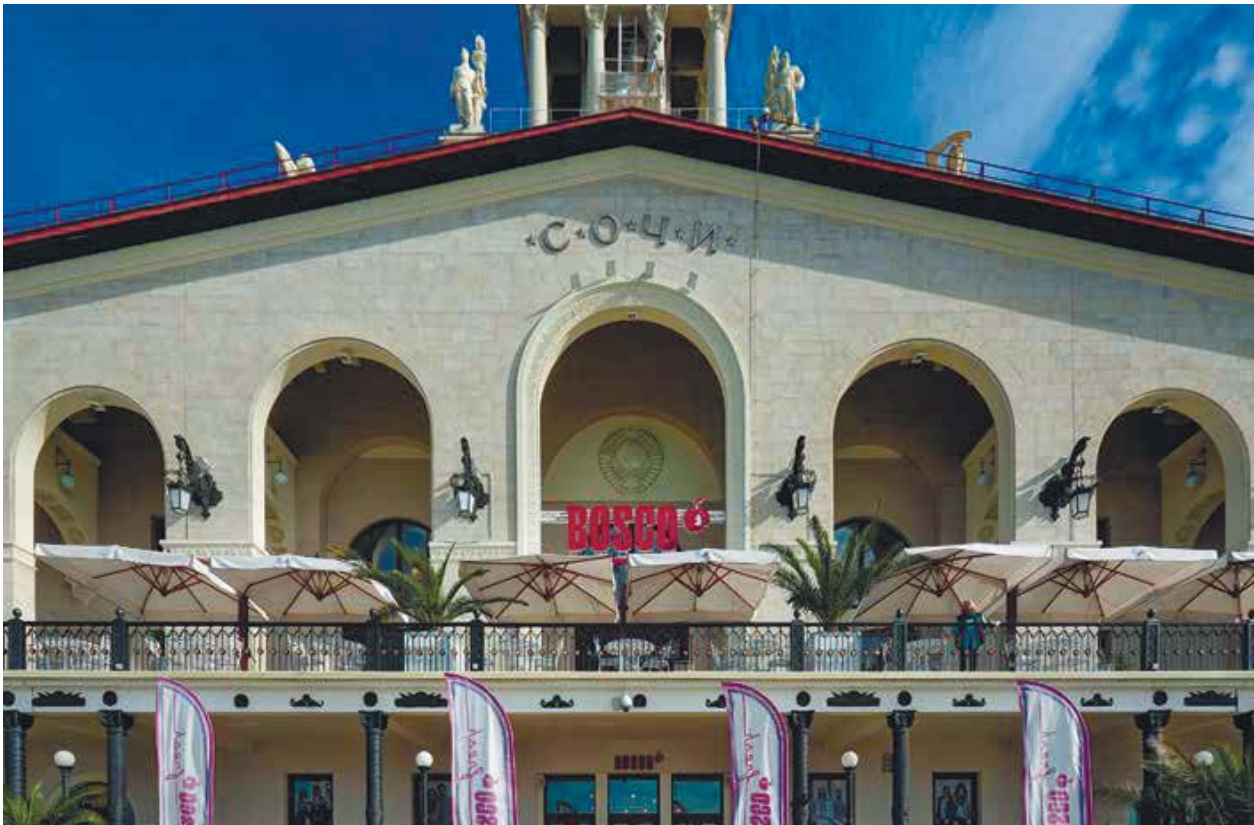
Фрагмент главного фасада с галереей со стороны моря
