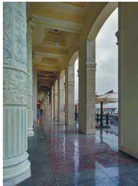
Боковая галерея главного фасада
