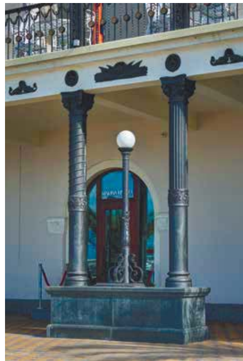
Фрагмент нижней галереи с чугунными колоннами
