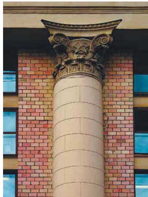
Колонна с композитной капителью
