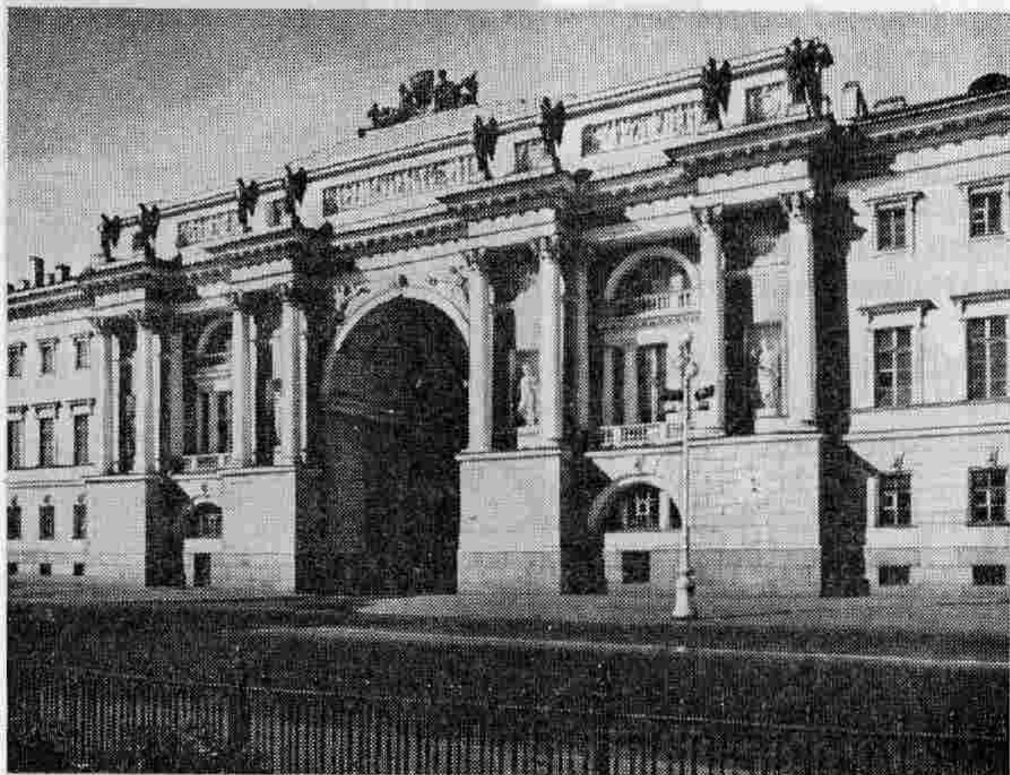
Арка зданий Сената и Синода.
