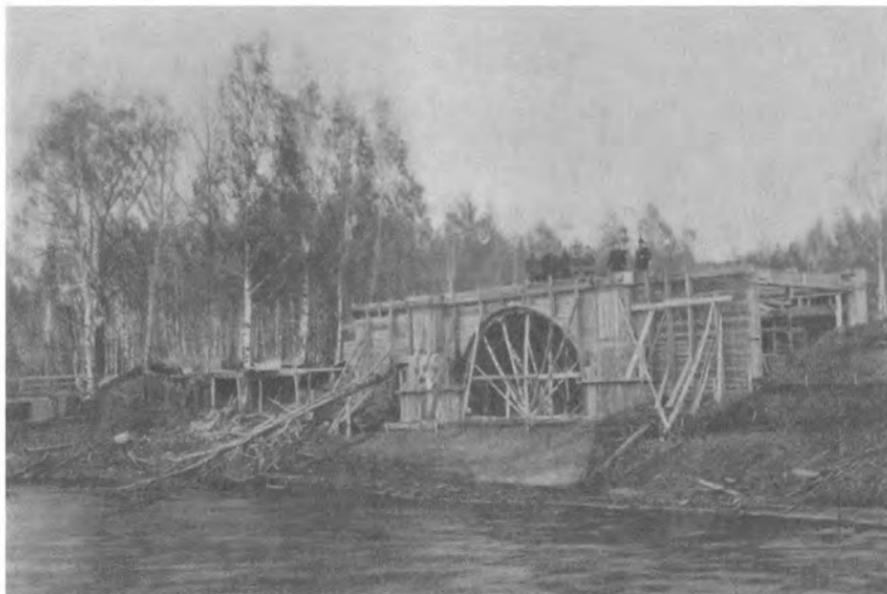
Строительство железобетонного моста в имении А.А. Руперти «Липовка». Архитектор И.В. Жолтовский 1907 г.
