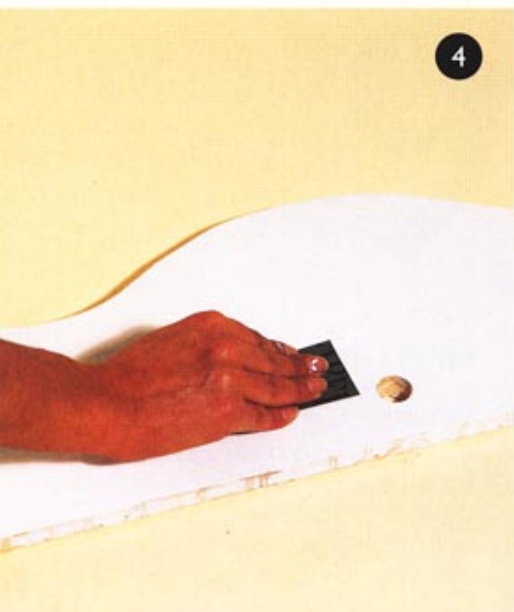
Фото 4. Обработайте загрунтованную поверхность наждаком, чтобы она стала абсолютно гладкой.
