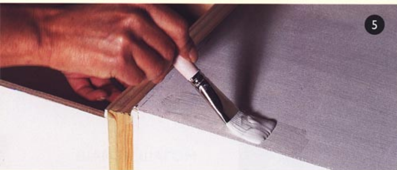
Фото 5. Затем нанесите второй слой грунтовки.
