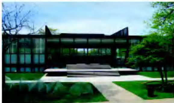
ЛЮДВИГ МИС ВАН ДЕР РОЭ ЗДАНИЕ АРХИТЕКТУРНОГО ФАКУЛЬТЕТА ИЛЛИНОЙСКОГО ТЕХНОЛОГИЧЕСКОГО ИНСТИТУТА, ЧИКАГО 1952–1956
