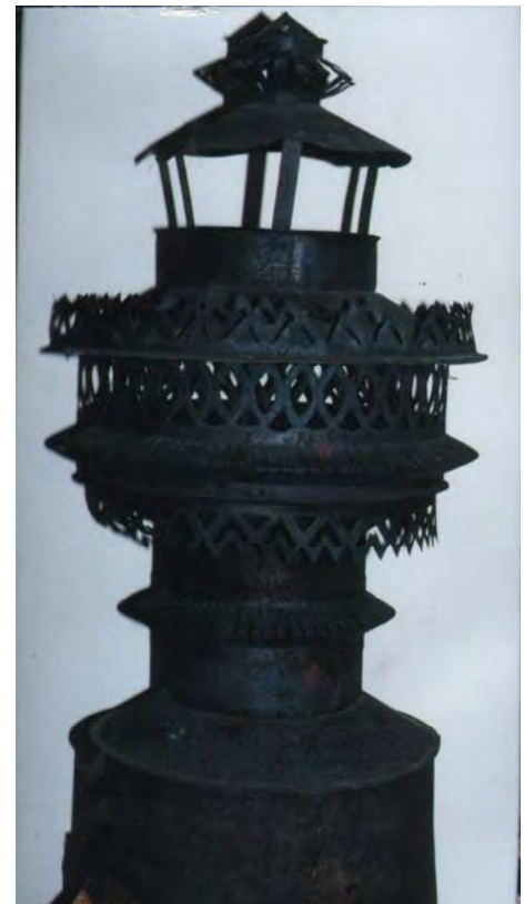
Рис. 5. Дымник. Просечённый металл
