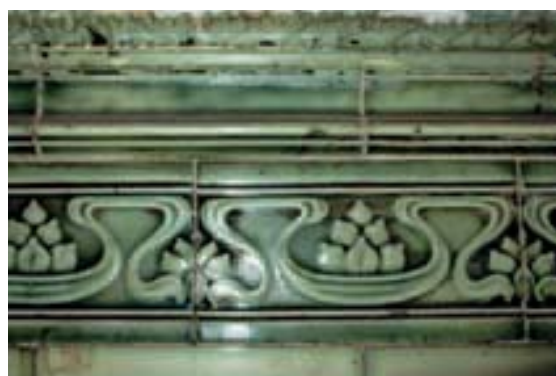
Керамическая облицовка лестничной клетки в доходном доме Я. М. Филатова (арх. В.Е. Дубовской, 1907–1909) Германия (?) Фото М. Фединой
