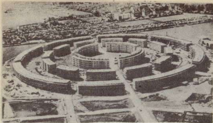
116. Жилой район в Лейпциге (фото 1930 г.). Эстетическая доктрина навязывала тенденцию заводского изготовления сборных элементов и применения сборных зданий
