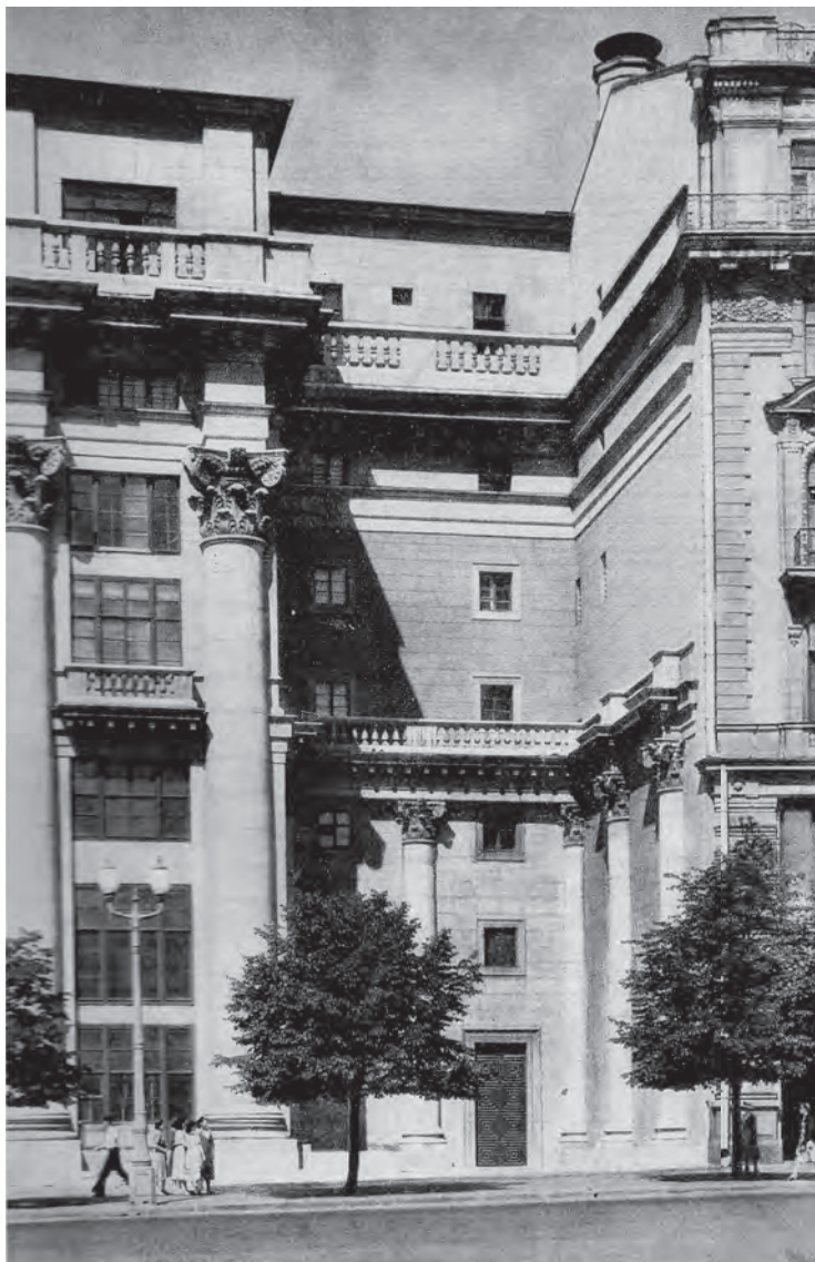
Фрагмент главного фасада
