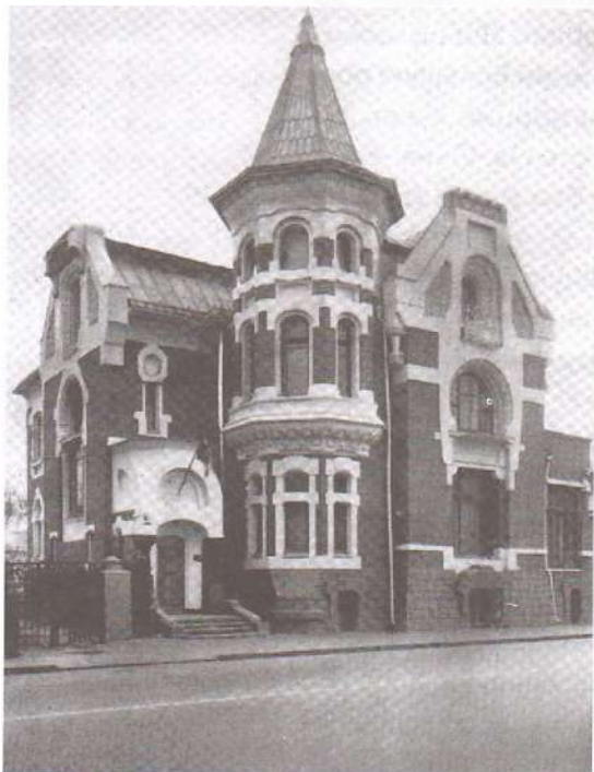
Л.Н. Кекушев. Особняк Кекушевой на Остоженке в Москве. 1903 г.
