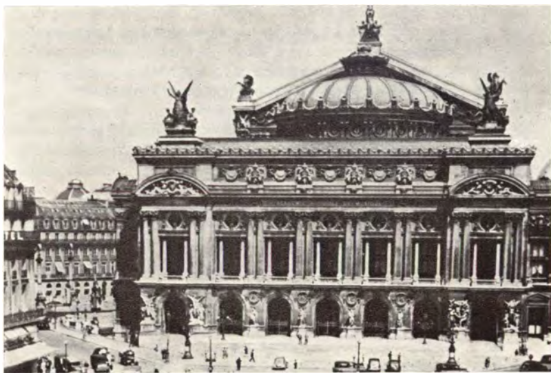
Гарнье. Здание Большой Оперы в Париже. 1862—1875. Главный фасад
