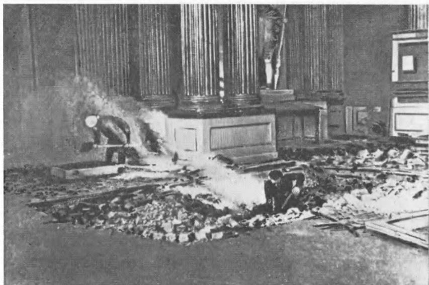
Снаряд разворотил междуэтажное перекрытие, и сквозь большую пробоину стала видна Растреллиевская галерея.
