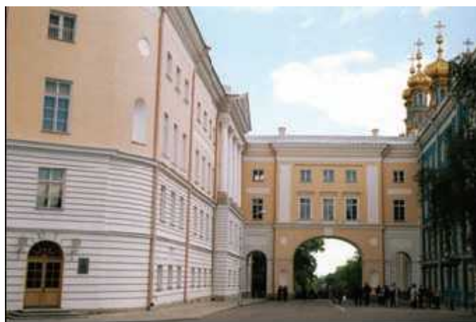
В. П. Стасов. Корпус Лицея. 1811 г. Царское Село
