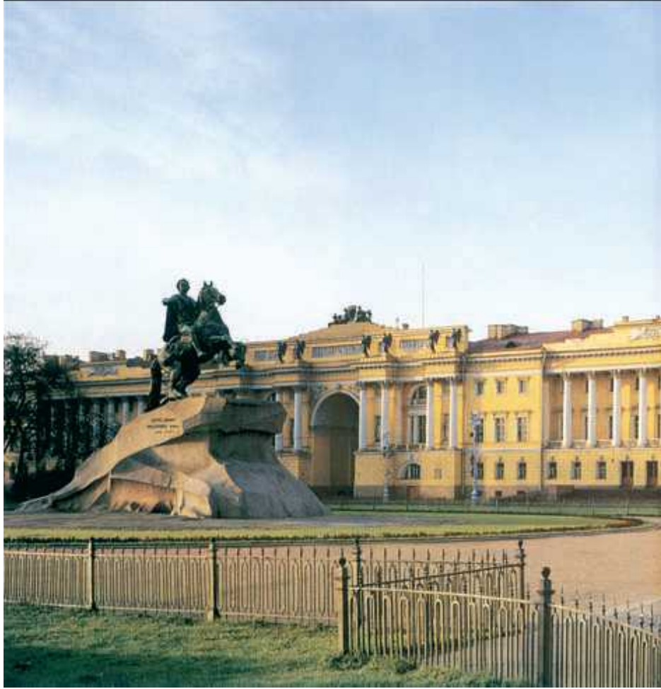
К. И. Росси. Здания Сената и Синода. 1829—34 гг. Санкт-Петербург
