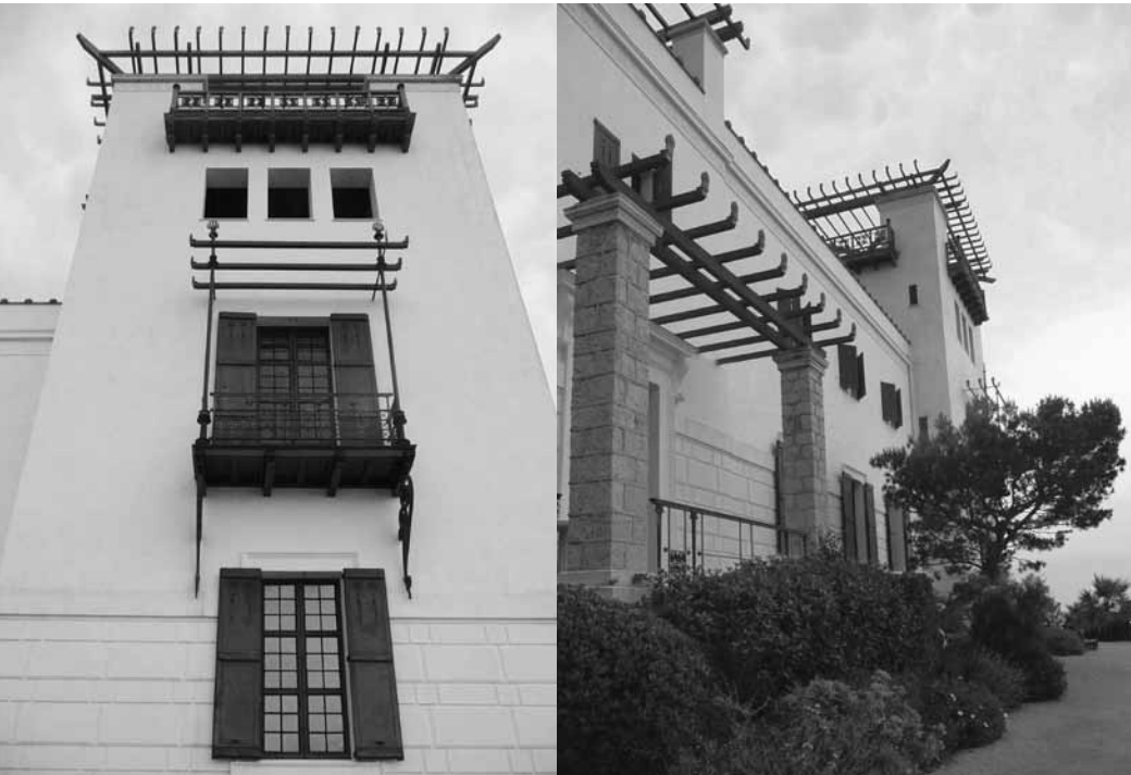
Фрагмент западного фасада виллы Керилос. Фото 2009 г.
