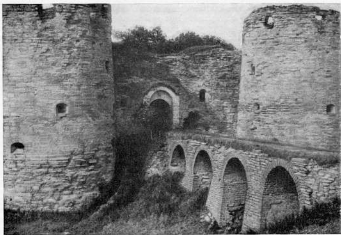
Копорье. Въездная арка крепости.
