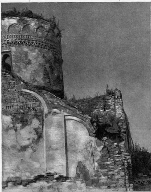
Церковь Дмитрия Солунского (1463) перед реставрацией 1949 года. Часть южного фасада.
