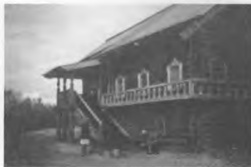
Дом в Заонежье
