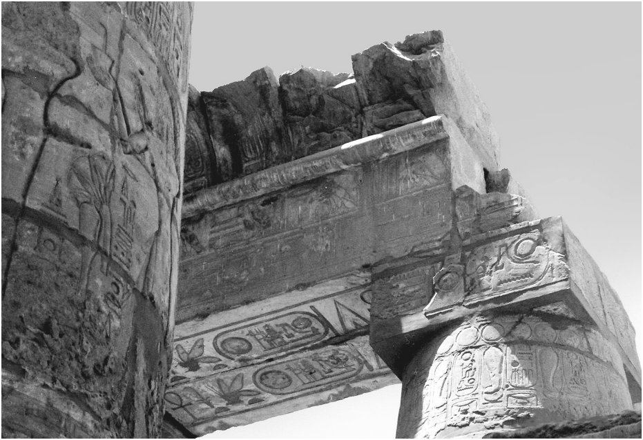
Рис. 43. Стоечно-балочная конструкция в Карнакском храме. Луксор. Египет
