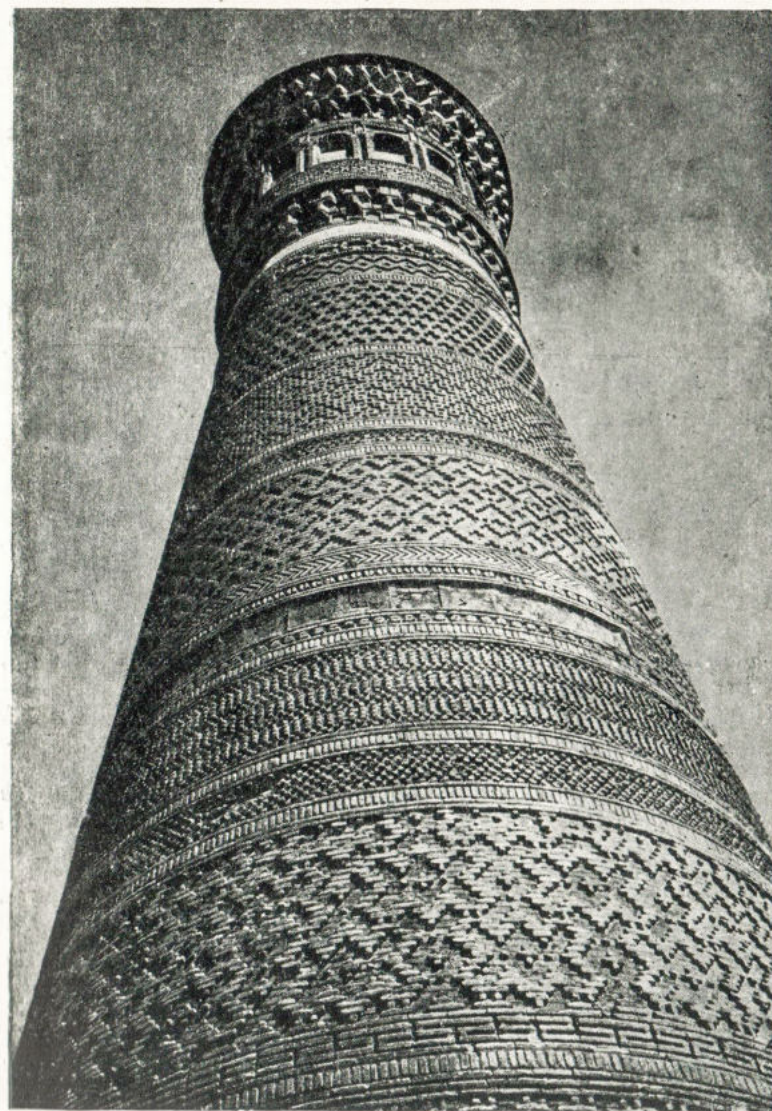
Рис. 40. Узорная кладка из неглазурованного кирпича. Большой бухарский минарет. 1127 год
