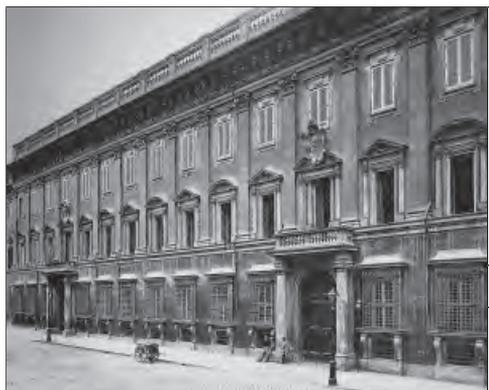
Композиция фасада решена как единая ордерная система. Нижний ярус изображен в виде цоколя под колоннадой. Пилястры перекрывают два этажа, а венчающий карниз под балюстрадой — общий для всего здания. Это — барокко, хотя и очень строгое.
