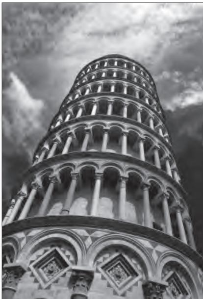
Очень жаль, что башня, часть большого храмового комплекса в Пизе, наклонилась. Привкус аттракциона отвлекает неискушенных туристов от ее божественной красоты. Многочисленные арочки замкнуты в кольца, что снимает проблему бокового распора. Строительство здания было начато 9 августа 1173 г., велось в два этапа, продолжалось почти 200 лет и завершилось в 1360 г.
