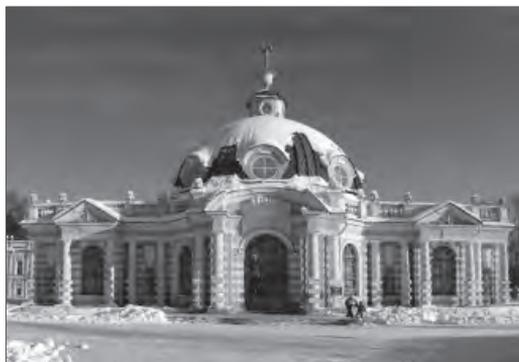
Волнообразная линия фасада, имитация рустованной кладки и муфтированные колонны буквально «взрывают» форму изнутри, «выбрасывают» массу здания во внешнее пространство.
