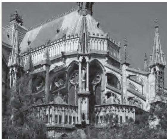
На восточном фасаде Реймского собора хорошо видны аркбутаны и контрфорсы, а также витражи, заменившие собой ставшие ненужными каменные стены. Алтарная часть храма окончена в 1241 г.
