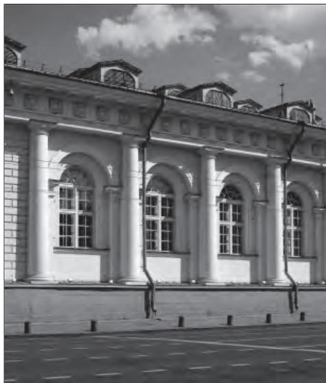
Московский образец тосканского ордера. Тосканский похож на дорический, однако архитравная балка здесь обычно тоньше, чем фриз, а колонны опираются на базу, но обходятся без каннелюр.
