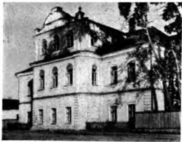
72. Дом Шилова. Вид с северо-запада. Снимок 1955 г.
