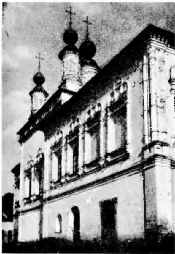
56. Мироносицкая церковь. Фрагмент северного фасада Снимок 1959 г.
