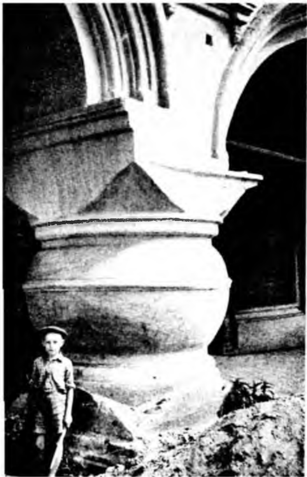
40. Надвратная Владимирская церковь. Опорный столб аркады. Снимок А. Г. Чинякова, 1955 г.
