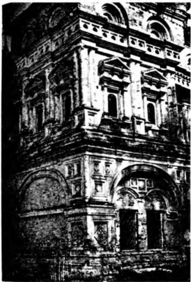
14. Церковь Вознесения. Фрагмент фасада южного придела. Снимок А. Г. Чанякова, 1977 г. Видны заложённые и вписанные арки первого этажа
