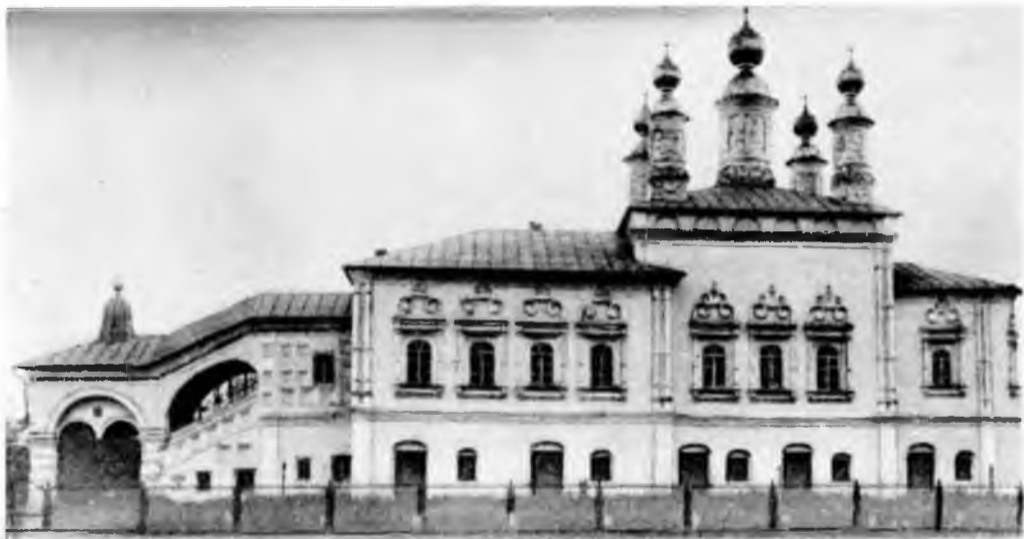
57 Мирноспитская церковь. Общий вид с юга (МАСиА)
