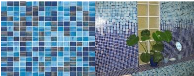
Рис. 10. Мозаичный ковер из мелкоформатных плиток (слева) и стена, облицованная ковровой керамикой (справа)
