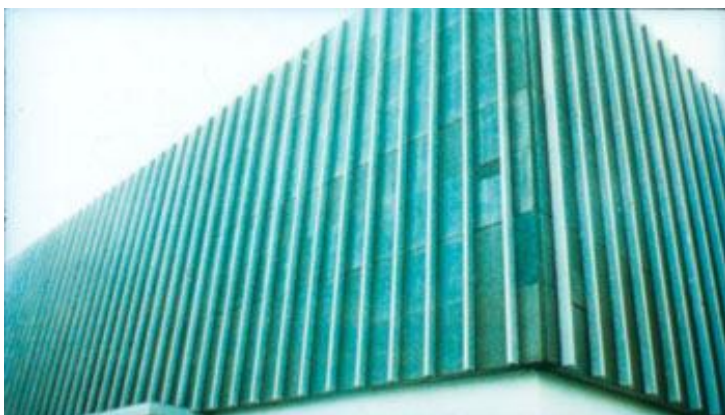
Рис. 48. Отделка фасада здания плитами из шлакоситалла
