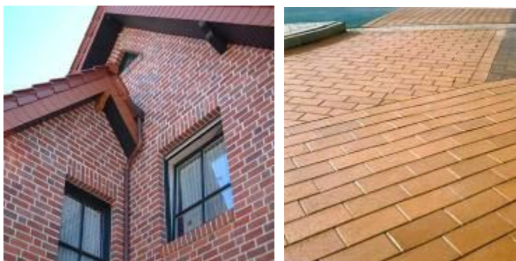
Рис. 18. Фасад здания (слева) и тротуарная дорожка (справа), выложенные из клинкерного кирпича
