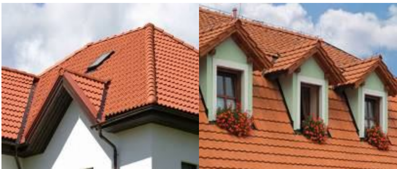
Рис. 16. Кровли, покрытые натуральной черепицей
