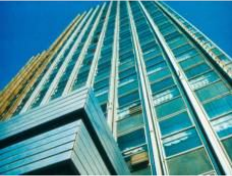
Рис. 34. Вид наружной облицовки административного здания листовым закаленным материалом «Стемалит»
