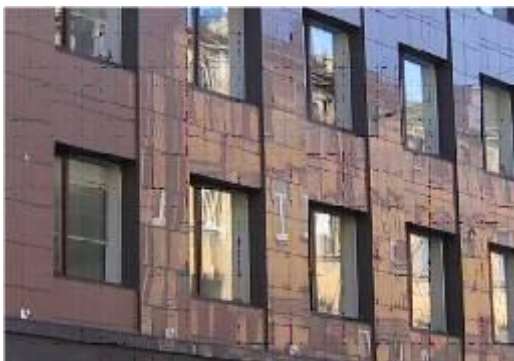
Рис. 9. Фрагмент фасада здания, облицованного керамогранитом
