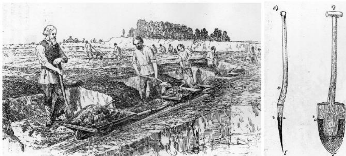
Рис. 15. Общий вид карьера, где добывали глину. Заступы для добычи глины
