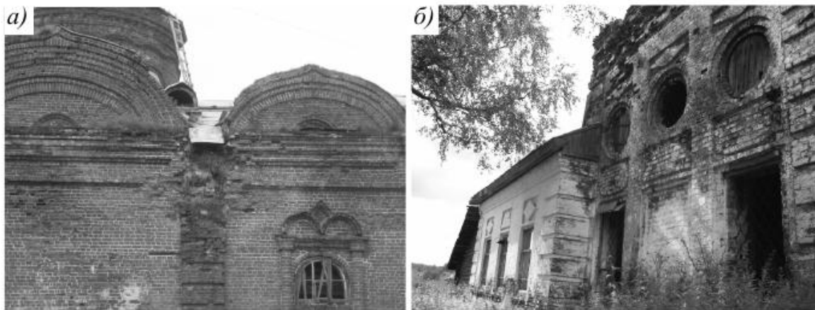
Рис. 55. а – Церковь иконы Пресвятой Богородицы «Нечаянная радость» (1914 г.), б – Михайло-Архангельская церковь в с. Архангельское (1809 г.)
