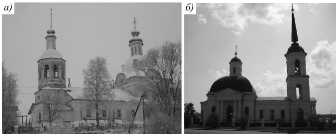
Рис. 7. Храмы продольной структуры с повышенным предалтарным объемом, завершенным сомкнутым сводом: а – Покровская церковь в с. Аксево Кирилловского района (1782 г.); б – церковь Рождества Христова в г. Череповце (1789/1997)
