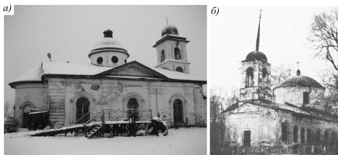
Рис. 10. Храмы продольной структуры без повышения предалтарного объема, завершенные куполом на высоком световом барабане: а – церковь Вознесения в г. Кириллове (1803 г.); б – Покровская церковь в с. Конечное Череповецкого района (1839 г.)
