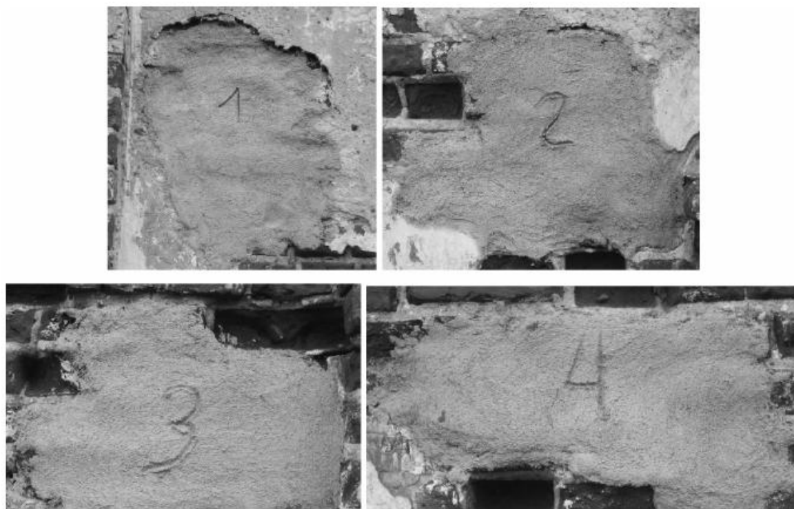
Рис. 76. Участок стены с нанесенными составами №1–4
