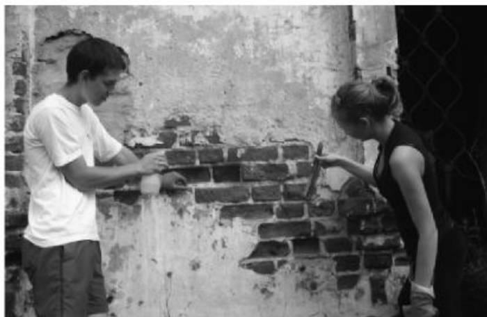
Рис. 75. Очистка и увлажнение поверхности кирпичной кладки
