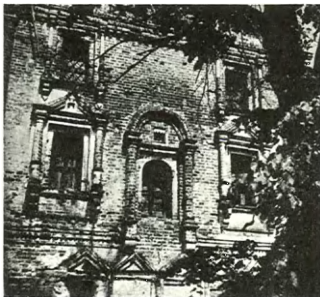
Полевщина. Казанская церковь. 1704. Фрагмент южного фасада
