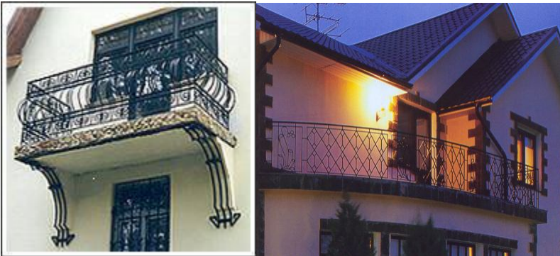
Рис. 10. Металлическое ограждение балкона ( слева ) и веранды ( справа )
