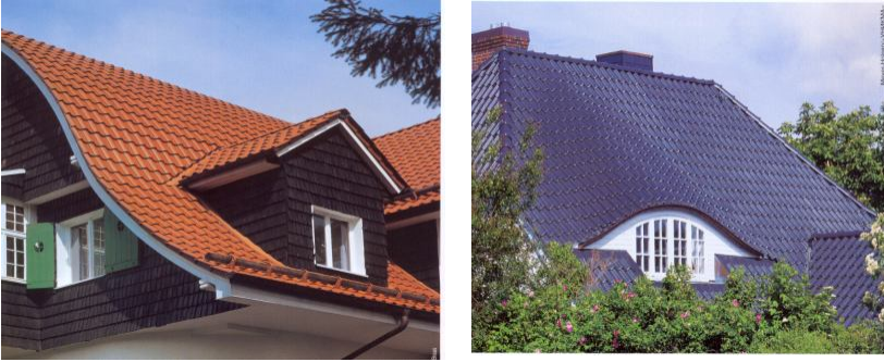
Рис. 18. Кровли, покрытые металлочерепицей
