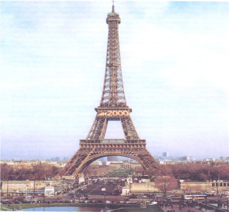
Рис. 2. Эйфелева башня в Париже, 1889 г. Инженер Г. Эйфель.
