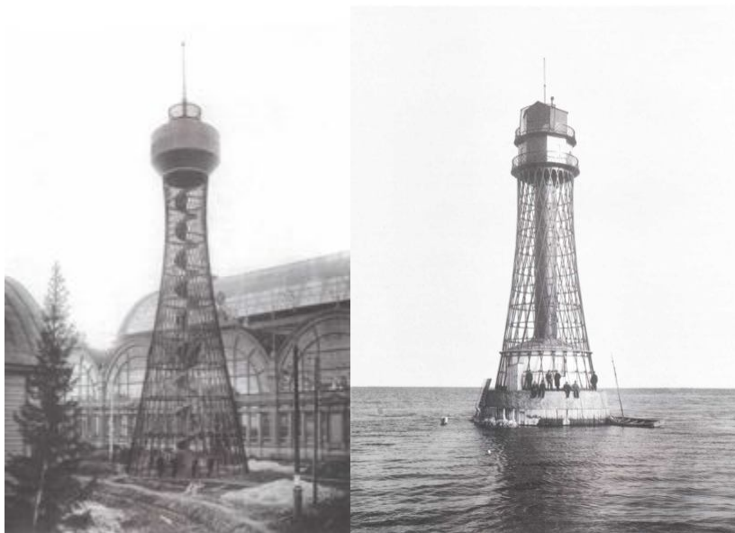
Рис. 3. Гиперболоидная водонапорная башня в Нижнем Новгороде, 1896 г. (слева). Инженер. В. Г. Шухов. Малый Станиславский маяк Херсонского порта, 1911 г. (справа). Инженер В. Г. Шухов.
