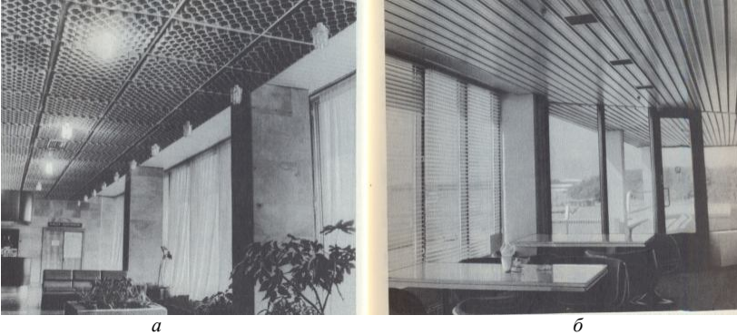
Рис. 11. Аллюминиевые подвесные потолки: а – в гостиничном комплексе в Измайлово (Москва), б – в центре парусного спорта в Таллине
