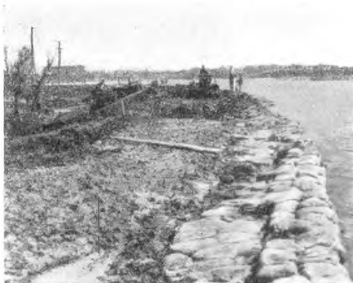
Рис. 270. Линдейлская защитная дамба (Виннипег) в начале строительства
