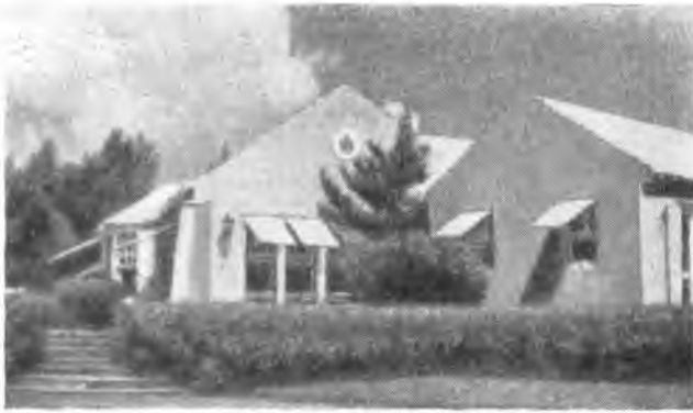
Рис. 100. Жилые дома на Бермудских островах. Видны венецианские жалюзийные ставни, прикрепленные к верху окон
