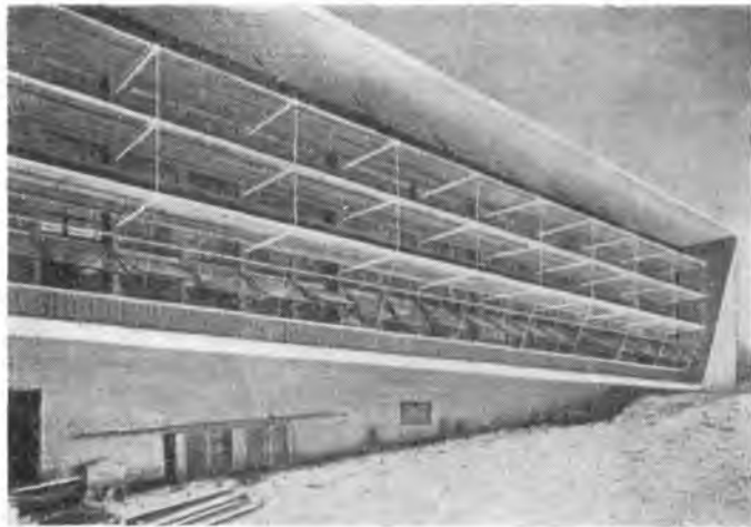
Рис. 81. Навес и тенты на южной стене корпуса университетской библиотеки в Сан-Антонио (Тринити)
