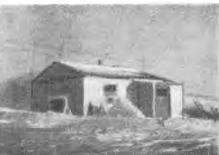
Рис. 249. Здание генераторной станции на озере Бейкер. Пример удачной ориентации
