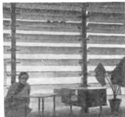
Рис. 94. Горизонтальные подвижные солнцезащитные устройства. Общежитие в Пондишери
