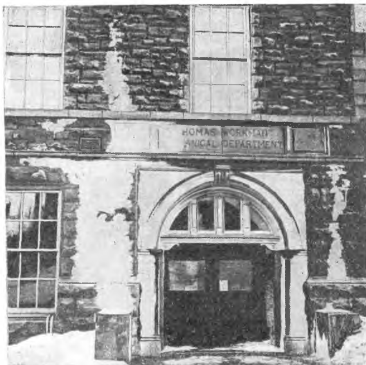
Рис. 281. Иней на стене около бокового входа в инженерный корпус Мак Джиллского университета
