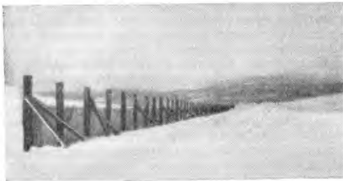
Рис. 244. Противоснежный забор с подкосами (Калифорния)
