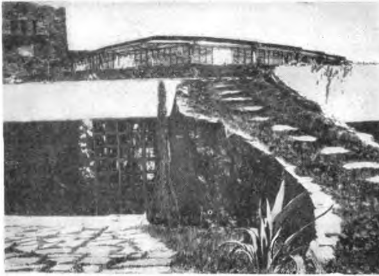
Рис. 182. Крыша с посеянной на ней травой, жилой дом в Мехико-Сити. Архитектор Карлос Лазо
