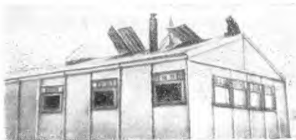
Рис. 203. Разрушительное действие ветра на алюминиевую крышу
