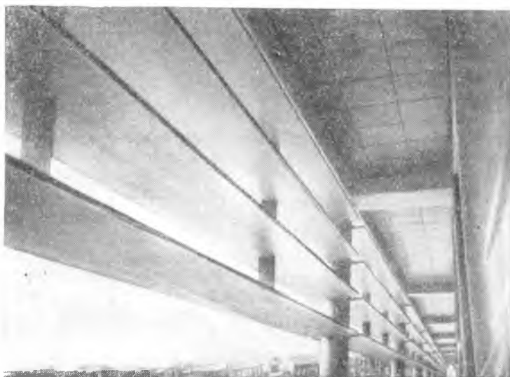
Рис. 90. Жалюзи, вид из здания
