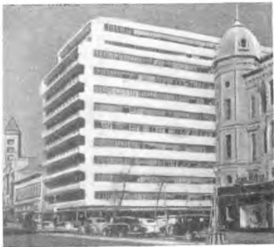
Рис. 84. Сочетание сплошных козырьков с балконами на западной стене «Дома Лонгфелло» (Вашингтон). Архитектор Вильям Лескейз
