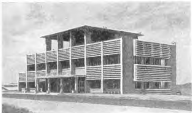
Рис. 92. Горизонтально закрепленные жалюзи на здании Большой нефтяной компании в Пуэрта де ла Крус, (Венецуэла). Архитекторы Вурхис, Уокер, Фолей и Смит
