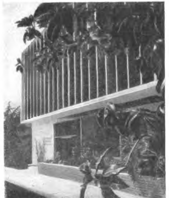
Рис. 98. Алюминиевые вертикальные подвижные жалюзи на южной стене здания Всеобщей противопожарной ассоциации Северо-Запада в Лос-Анжелесе. Архитектор Ричард Ньютра
