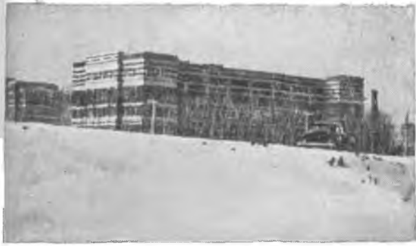
Рис. 272. Дамба у дороги Черчилля, построенная для защиты района, примыкающего к реке и городскому госпиталю (Виннипег)
