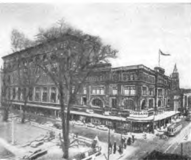
Рис. 251. Вид с юго-запада на универсальный магазин Морганов в Монреале. Виден крытый тротуар для пешеходов
