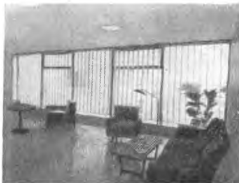
Рис. 99. Внутренние вертикальные подвижные солнцезащитные устройства из холста в Доме для престарелых. Канзас-Сити (Миссури). Архитекторы Киветт и Мейерс
