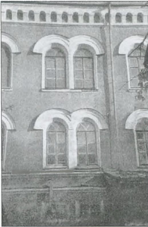
Мужская гимназия. Фрагмент торцового фасада
