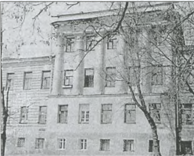
Школа кантонистов. Главный фасад
