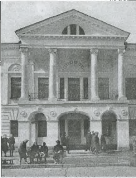
Дом Тулиновых. Фрагмент фасада
