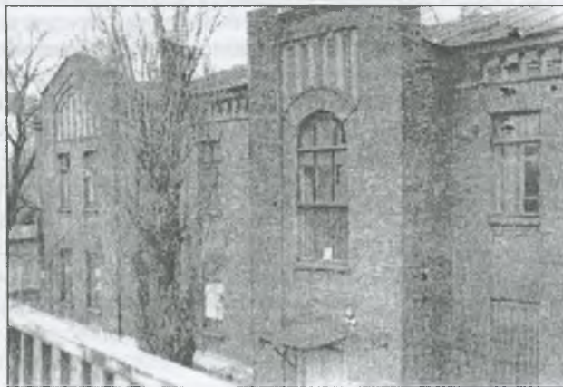
Дом при Отрожских мастерских, ул. Б. Хмельницкого, 13
