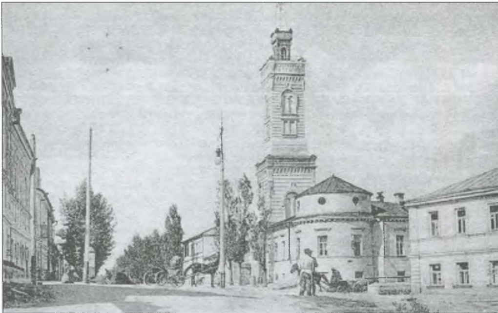
Мещанская полицейская часть с пожарной каланчой
