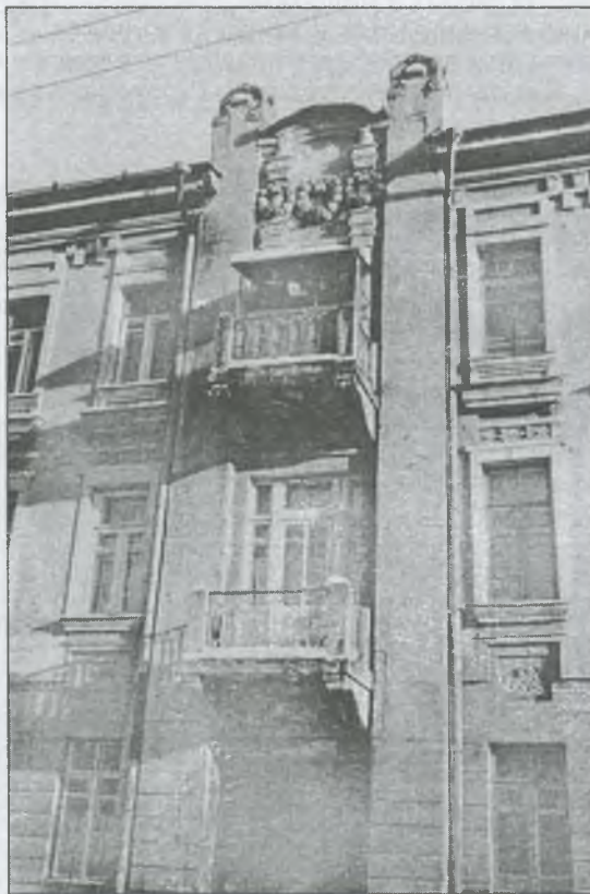
Дом Мануйлова. Фрагмент главного фасада
