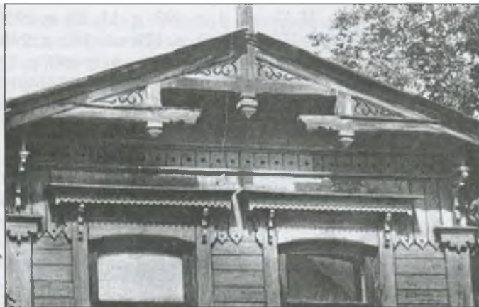
Флигель Либана. Фрагмент фасада
