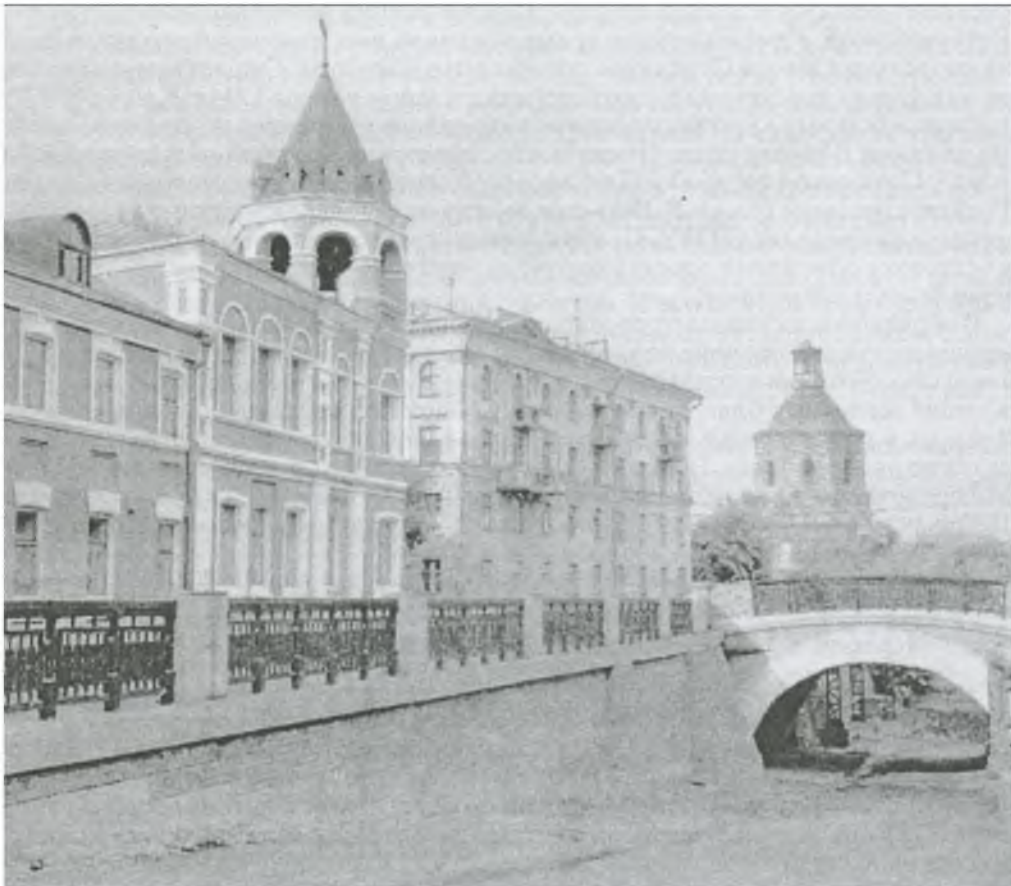
Каменный мост с западной стороны
