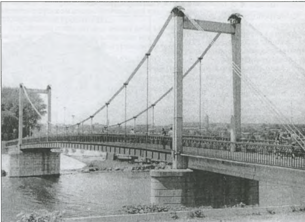
Подвесной мост на Чернавской дамбе
