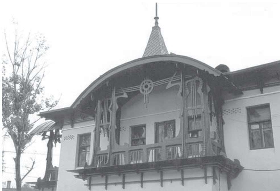
Балкон особняка на Большом проспекте
