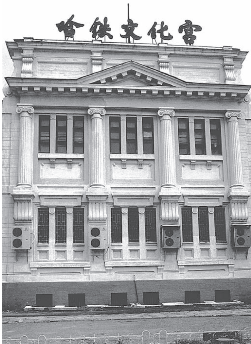
Фрагмент фасада здания Железнодорожного собрания
