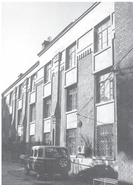
Фрагмент бокового фасада костела. Современный вид
