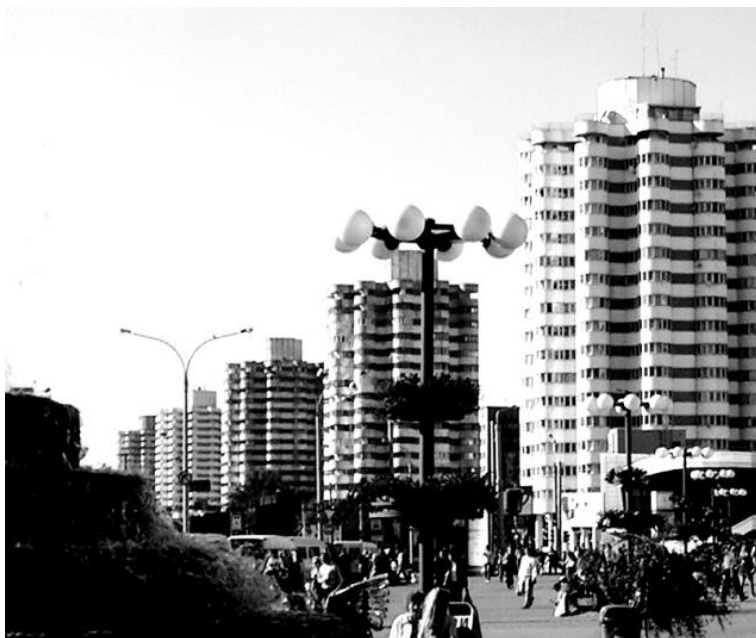
Рис. 2.23. Метрическое построение композиции жилых зданий-башен (архит. В. Пушкин) вдоль улицы В. Хоружей в Минске
