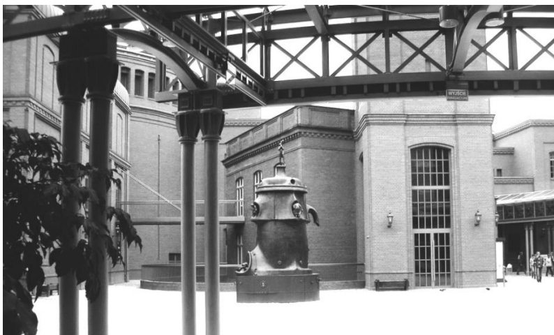
Рис. 3.3. В пространственной композиции торгово-общественного центра «Старый бровар» использована стилистика исторической производственной застройки, Познань, Польша
