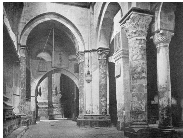
Колоннада северного нефа Храма Воскресения Господня в Иерусалиме, фото Н. П. Кондакова
