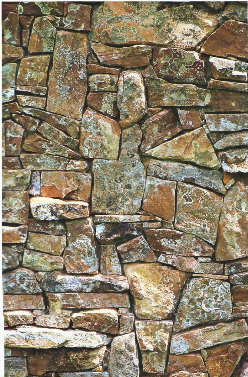
Фрагмент кладки наружной стены демонстрирует впечатляющую работу квалифицированного каменщика
