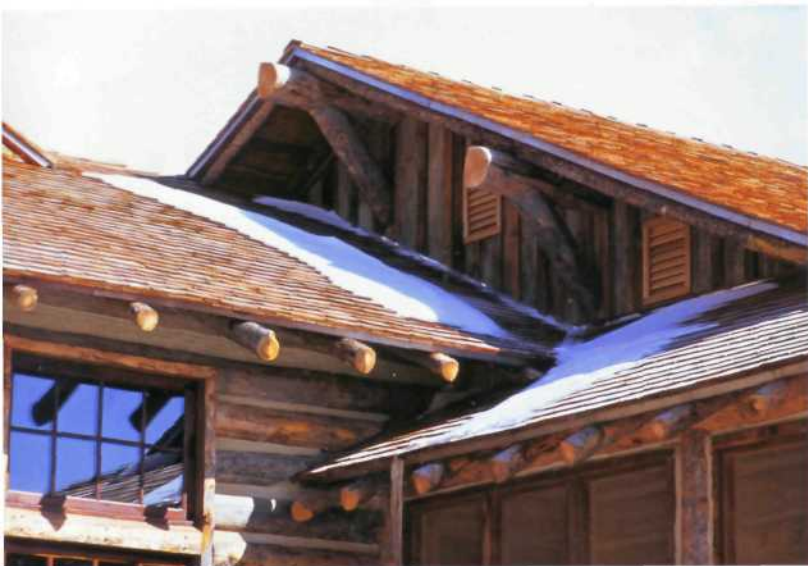
Детали разноуровневой крыши в зданиях кемпинга «Два лося»
