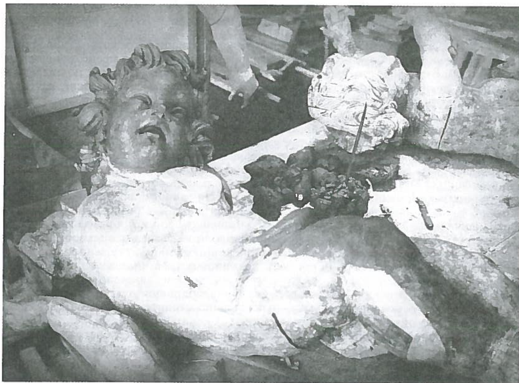
169. Екатерининский дворец. Большой зал. Восполнение утрат фигурки путти в пластилине до формовки, отливки моделей утрат в гипсе и воссоздания их в дереве
