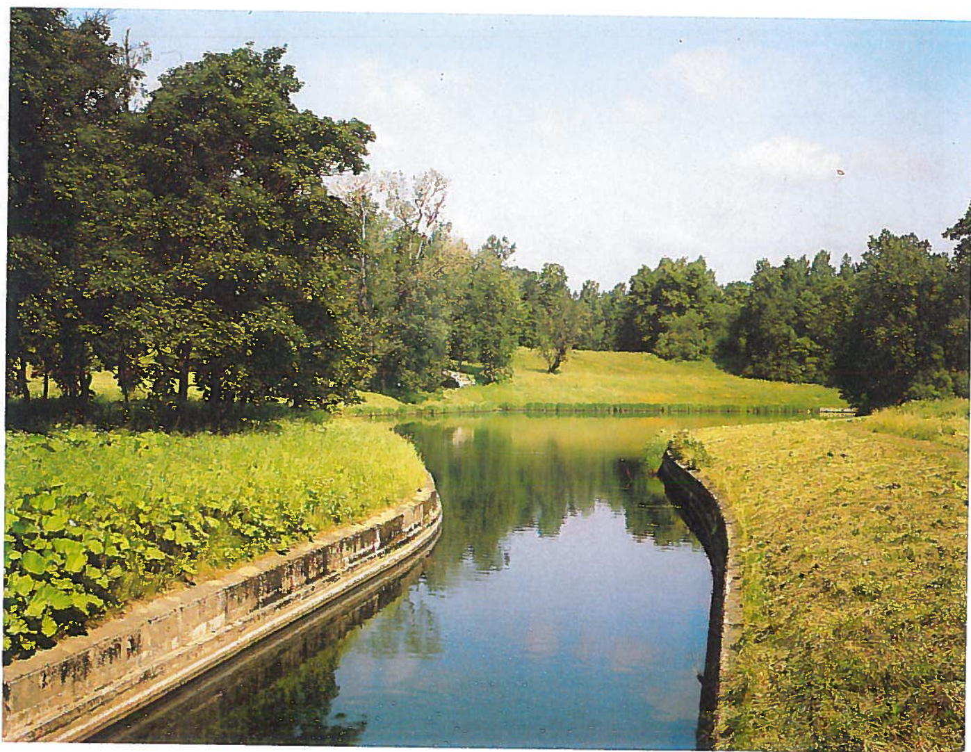
20. Берегоукрепления реки Славянки бетонными конструкциями
