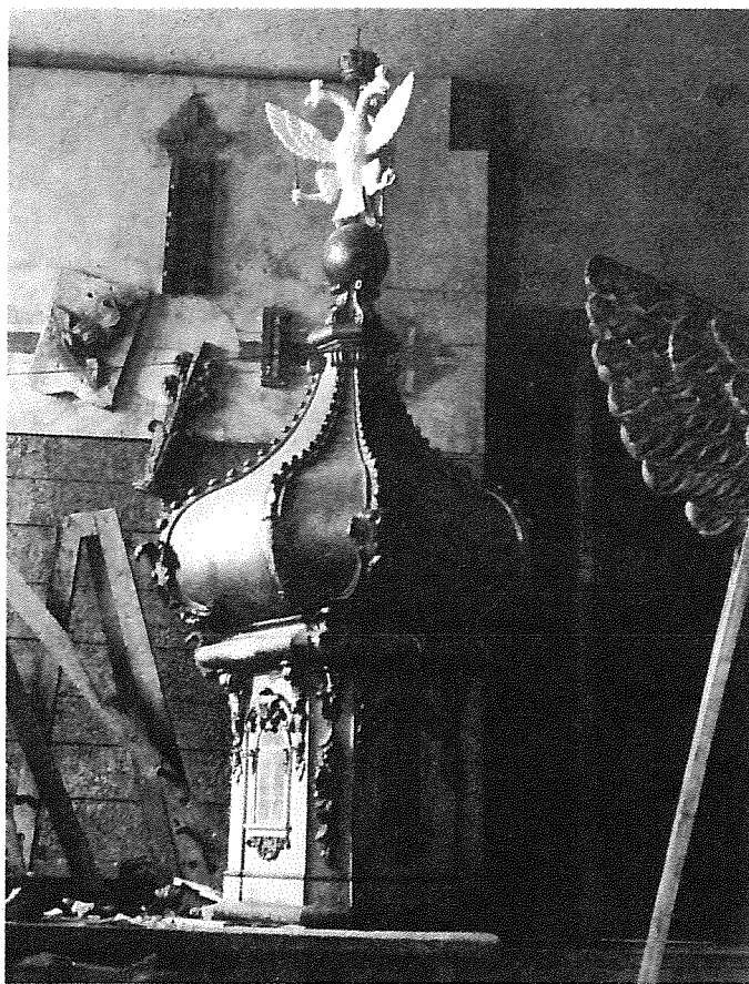
82. Большой дворец в Петергофе. Корпус под гербом. Законченная модель барабана и маковицы. Справа виден конец крыла — начатой модели орла в натуральную величину
