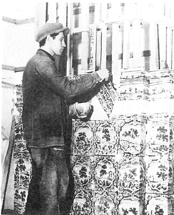
107. Екатерининский дворец. Картинный зал. Сборка отреставрированных изразцов на временном каркасе печи
