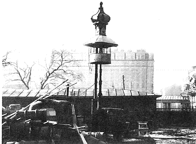
81. Большой дворец в Петергофе. Корпус под гербом. Проверка на ракурс модели барабана и маковицы. Подъем телескопической вышки и фотографирование с заданных точек
