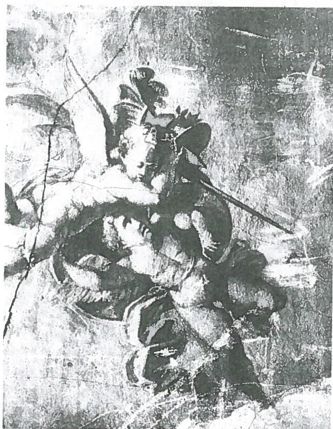
148. Горный институт. Колонный зал. Состояние фрагмента сохранившейся живописи центральной картины до расчисток и расшивки трещин в штукатурке
