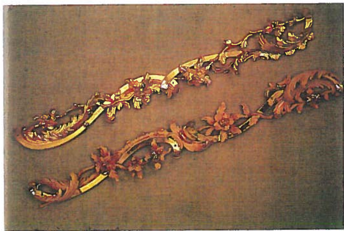
32. Екатерининский дворец. Подготовка под золочение, резьба по левкасу и начало золочения на полимент
