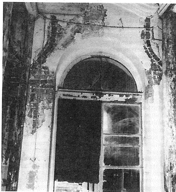
48. Троице-Сергиева пустынь. Дом настоятеля. Фотография раскрытия обрамления дверного проема бельэтажа южного фасада
