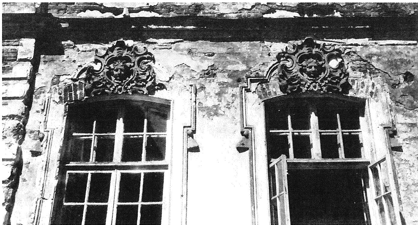
27. Екатерининский дворец. Пробные раскрытия ниш, замурованных под междуэтажным карнизом. 1957
