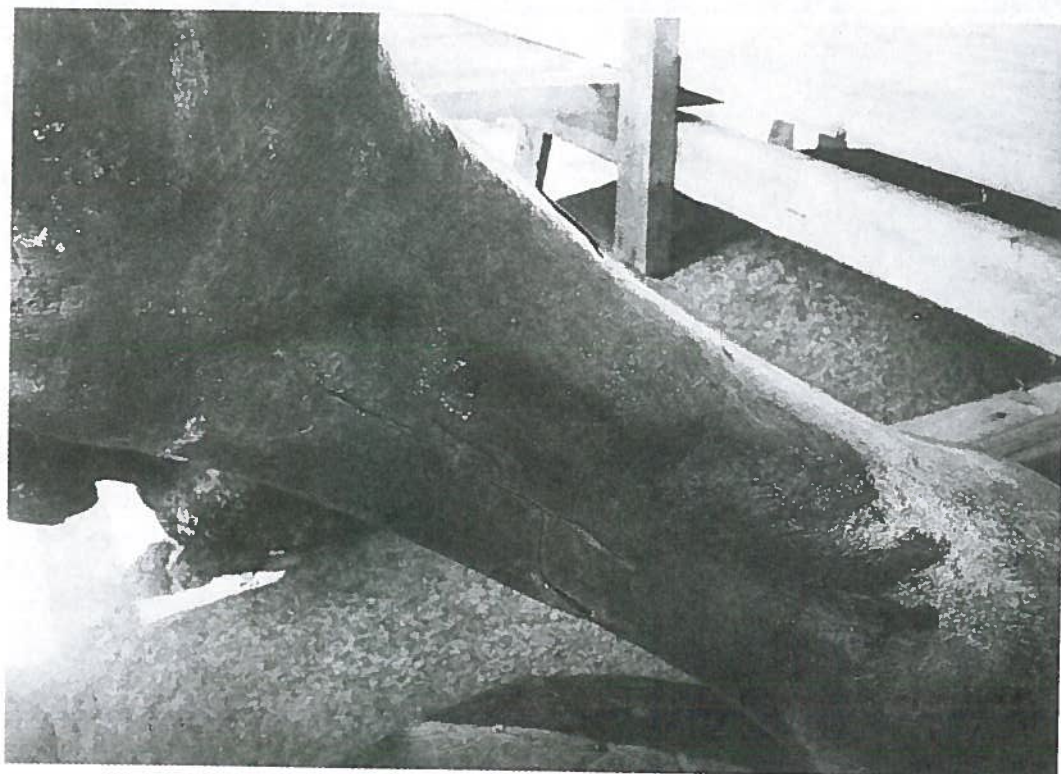
179. Санкт-Петербург. Памятник Петру I. Трещины в бронзовой отливке передней ноги коня, возникшие от скопления конденсата внутри скульптуры
