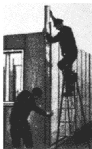
1 Дома в Финове: а — монтаж сборных стен; б — угол дома закрыт медной полоской; с — вертикальный разрез стенового элемента; д — горизонтальный разрез и соединение стеновых элементов
